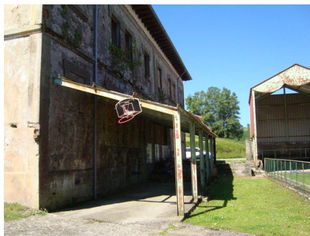
Fachada norte desde esquina este
