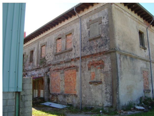
Fachadas norte y oeste
