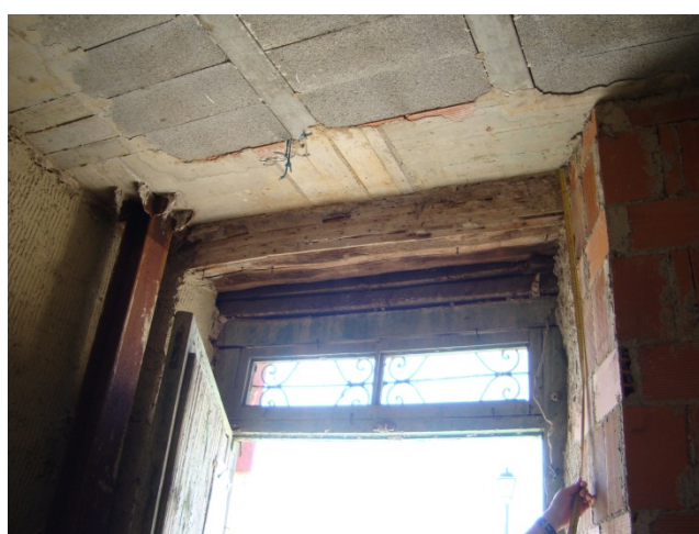
Interior, zona de puerta de acceso
