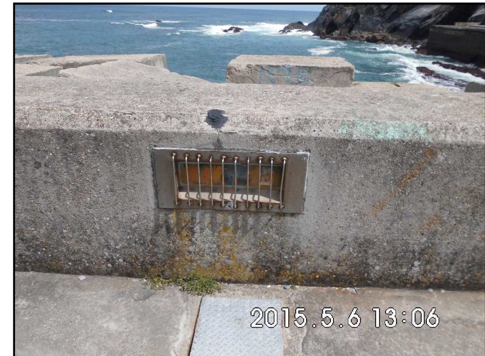
Vista General de Puntos de Luz Existente muro Dique.
