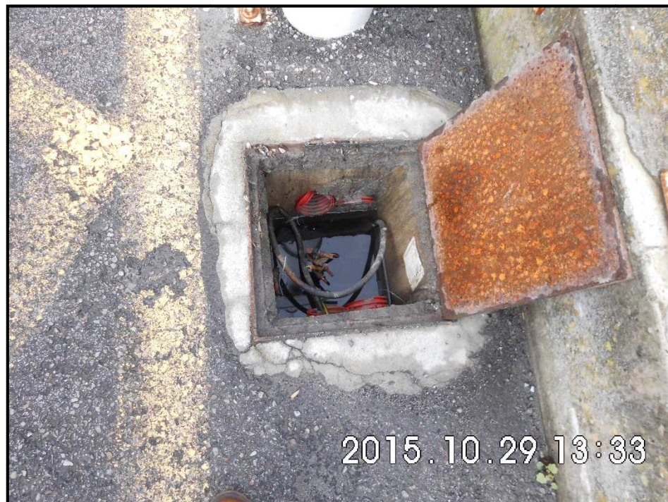
Vista del Estado de la Puesta a Tierra Existente
