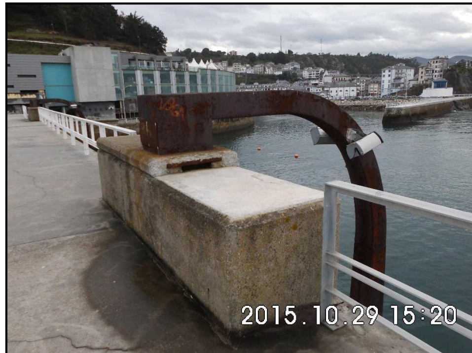
Vista General elemento de hormigón soporte de estructura metálica a reponer.
