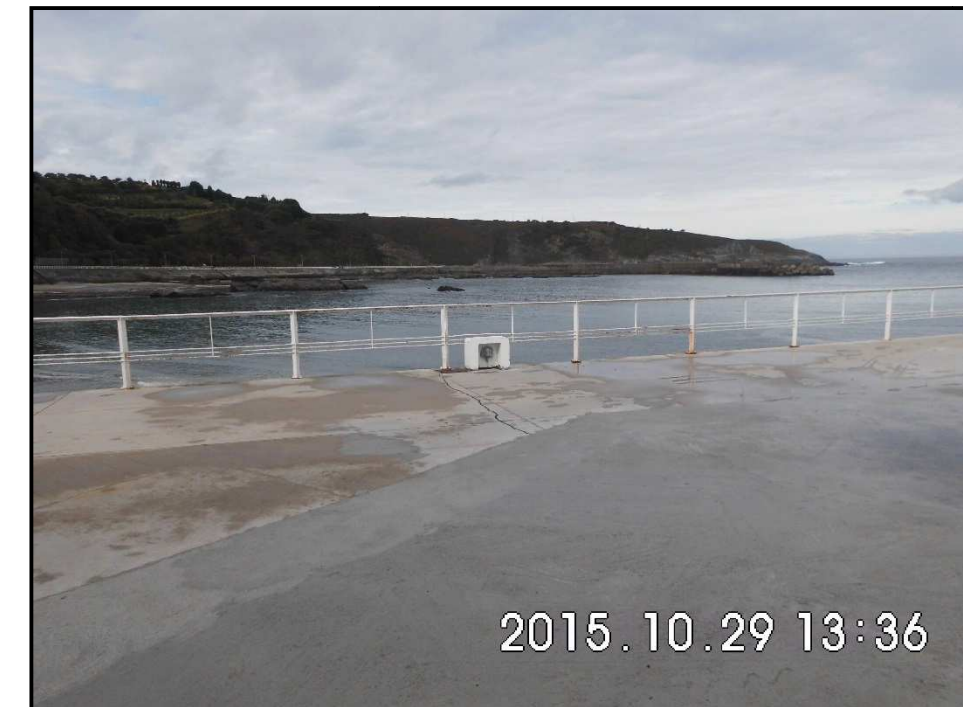
Vista General Punto de Luz en peana, existente en dique.
