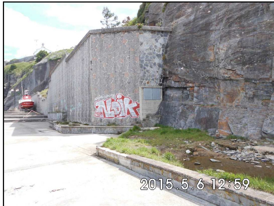
Vista General de la ubicación del Armario de Mando y Protección.
