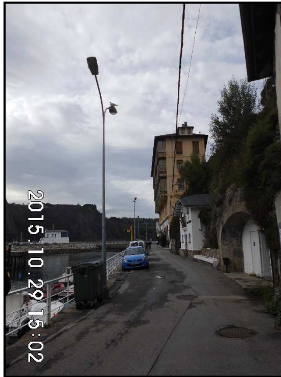
Vista General Punto Luz Tipo Industrial a Sustituir.
