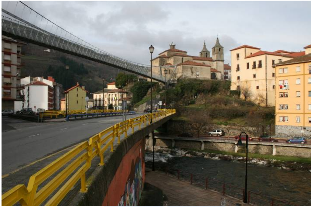
Puente sobre el río Narcea en Cangas
