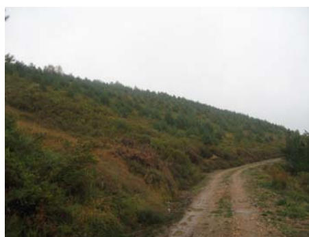
Pista 1, Mejora de capa de rodadura
