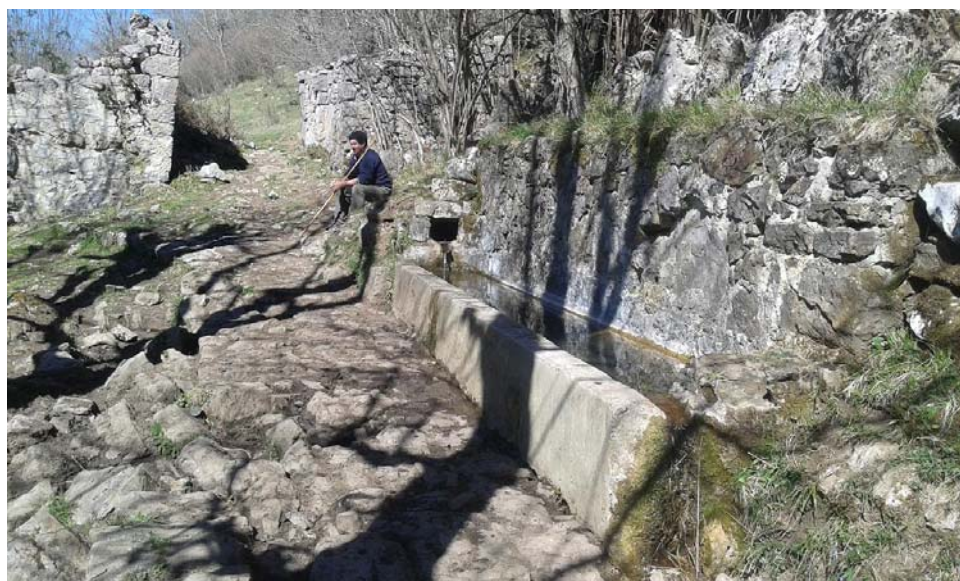
6- Vista abrevadero a reparar.
