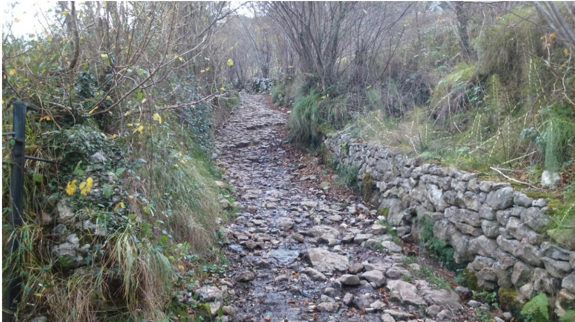
Foto 4: Muros de mampostería sosteniendo el talud del camino.
