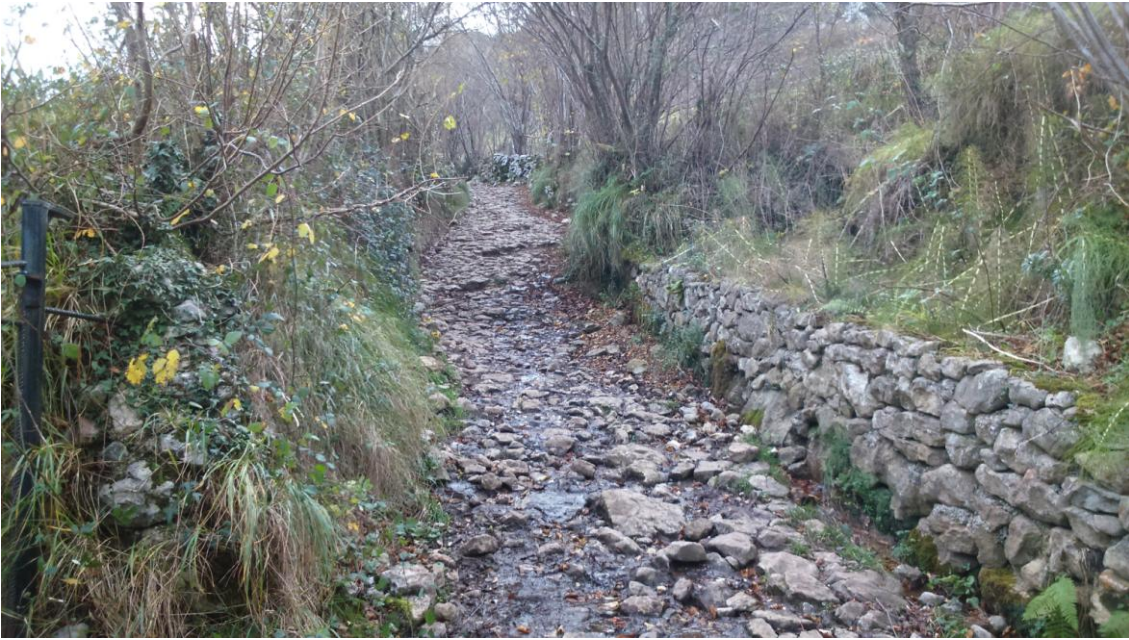
Foto 4: Muros de mampostería sosteniendo el talud del camino.
