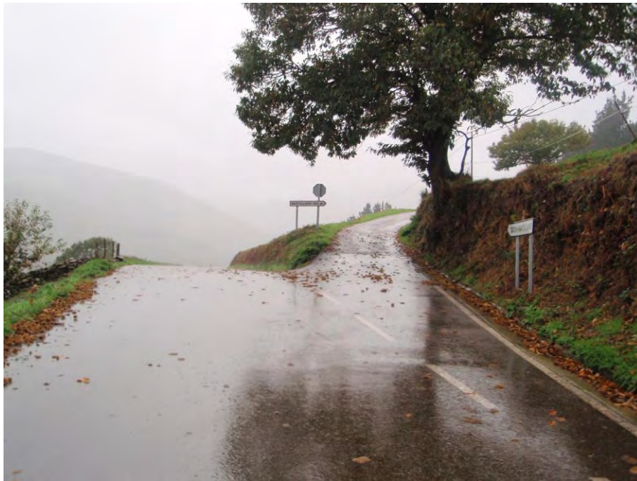
Foto 7: Enlace actual del Camino de Santullano con la Carretera Local ALL-1.
