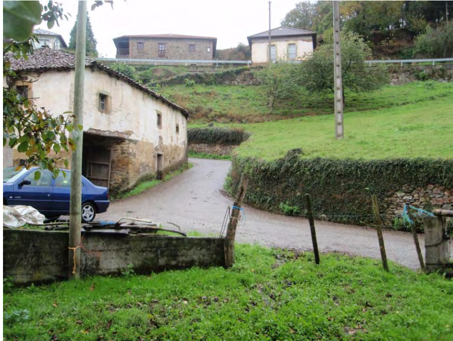
Foto 8: Vista de la zona de curva y contra-curva del camino a ensanchar.
