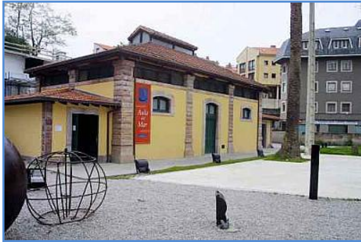
Vista exterior del Aula del Mar. Fuente www.llanes.com
