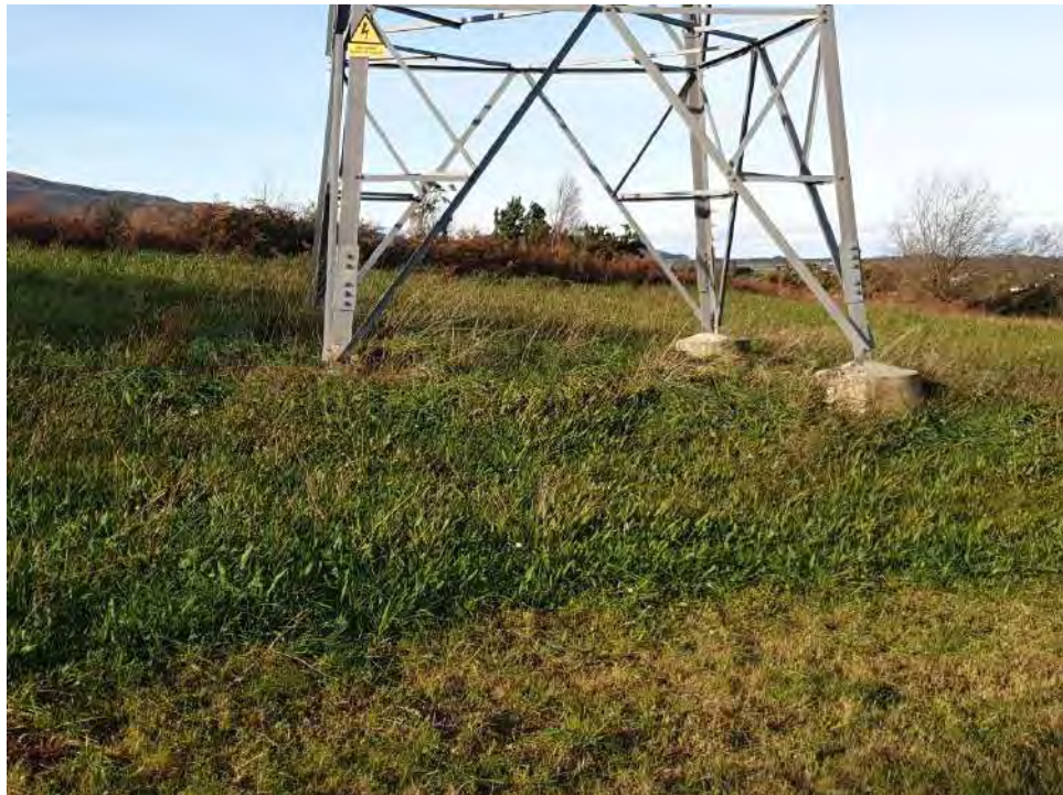
Figura 8 – Apoyo 1 tramo Sub. Almuña - Chano Canero (21/12/2020).
