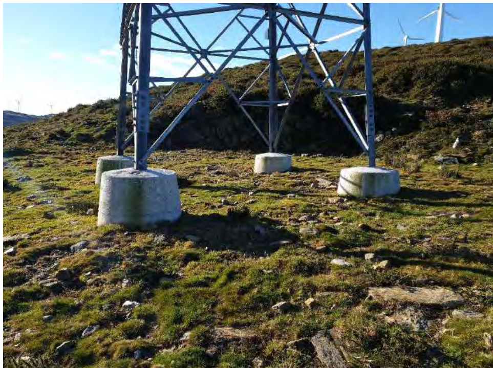
Figura 14 – Apoyo 66 tramo Chano Canero - Sub. Pico Gallo (15/12/2020).
