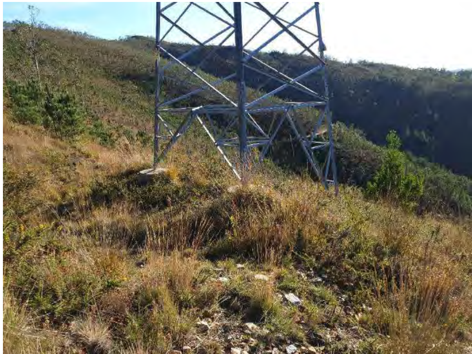
Figura 11 – Apoyo 28 tramo Chano Canero - Sub. Pico Gallo (21/11/2020).
