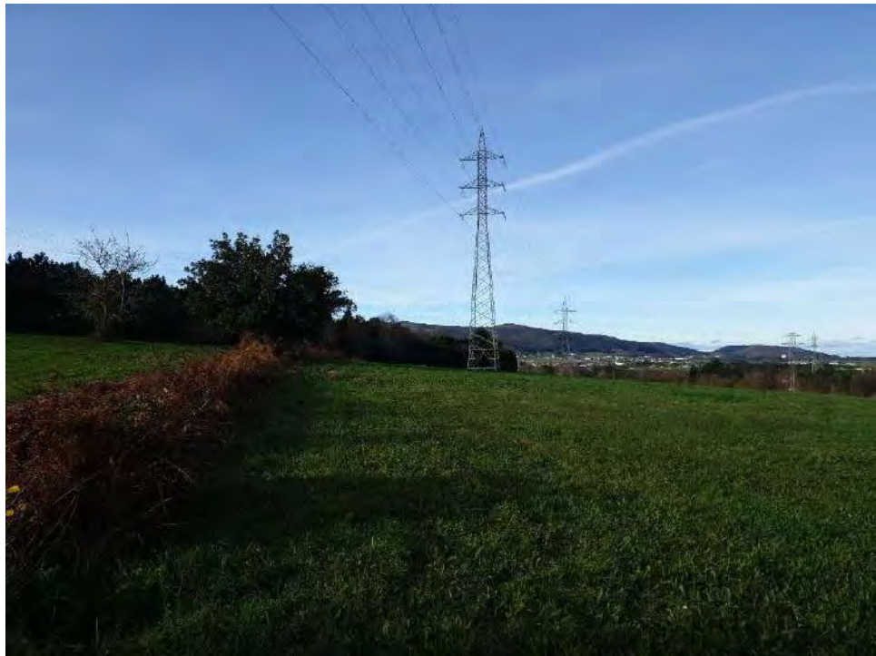
Figura 19 – Vano 2-3 tramo Sub Almuña – Chano Canero (21/12/2020).
