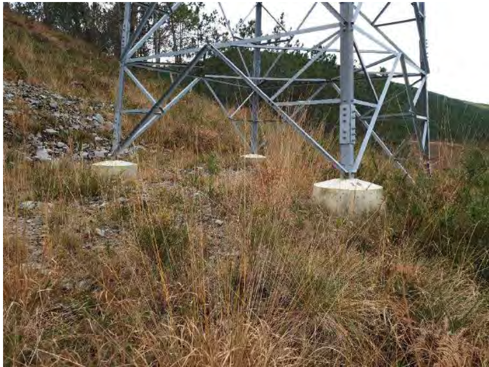
Figura 9 – Apoyo 16 tramo Sub. Almuña - Chano Canero (19/01/2021).
