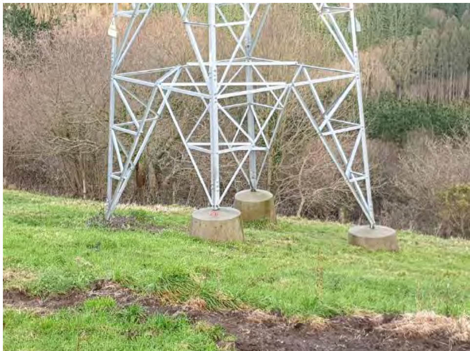
Figura 12 – Apoyo 48 tramo Chano Canero - Sub. Pico Gallo (24/01/2021).
