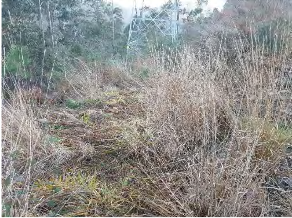
Figura 16 – Acceso apoyo 26 tramo Sub. Almuña - Chano Canero (19/01/2021).
