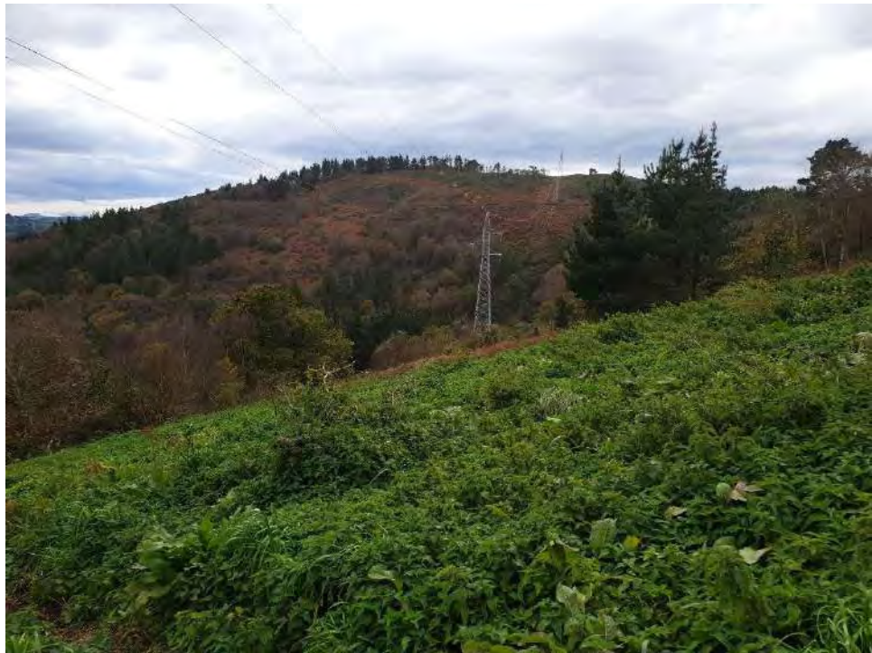
Figura 21 – Vano 50-51 tramo Chano Canero – Sub. Pico Gallo (01/11/2020).
