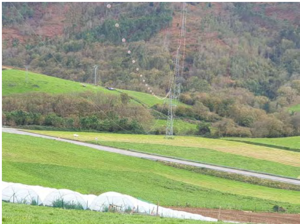
Figura 20 – Vano 12-13 tramo Chano Canero – Sub. Pico Gallo (08/11/2020).
