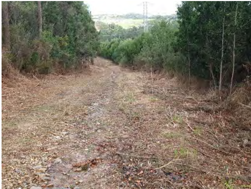
Figura 24 – Labores de desbroce en la calle paralela al vano 5-6 del tramo Sub. Almuña-Chano Canero.
