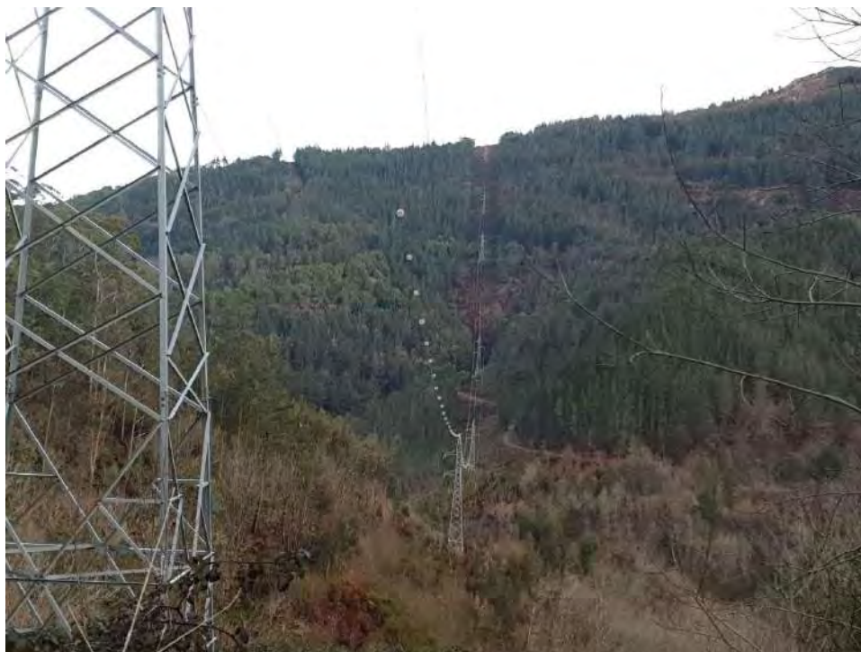
Figura 25 – Salvapájaros en el vano entre los apoyos 43 y 44 del tramo Chano Canero-Sub. Pico Gallo.
