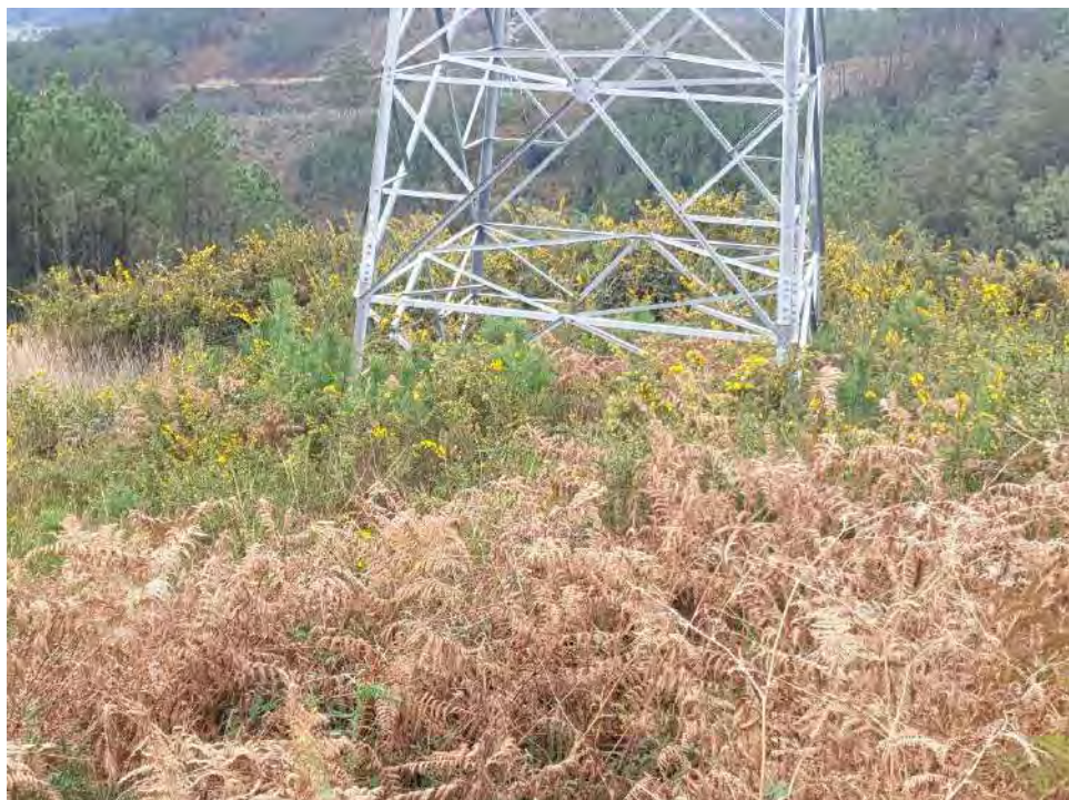
Figura 10 – Apoyo 8 tramo Chano Canero - Sub. Pico Gallo (08/11/2020).
