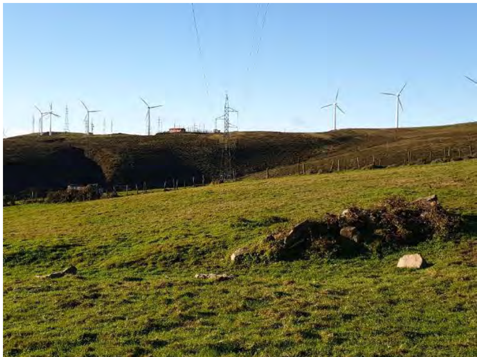
Figura 22 – Vano 70-71 tramo Chano Canero – Sub. Pico Gallo (15/12/2020).
