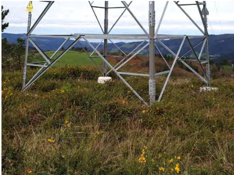
Figura 13 – Apoyo 53 tramo Chano Canero - Sub. Pico Gallo (01/11/2020).
