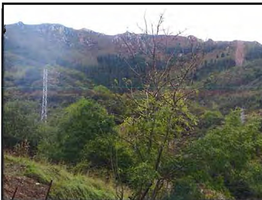
Conductor simple circuito con salvapájaros entre los apoyos nº 3 y nº 4
