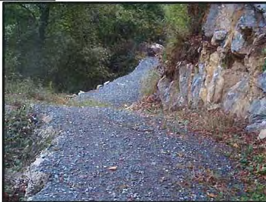
Acceso al apoyo nº 6:
