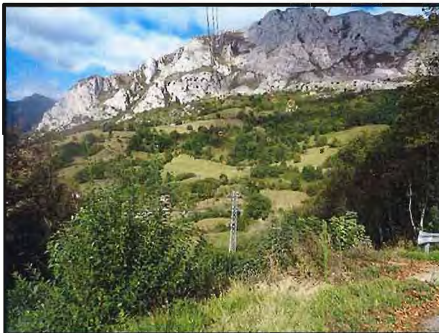
Conductor doble circuito con salvapájaros en el apoyo 15 (en la fotografía)
