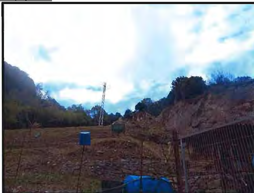
Acceso al apoyo nº 4:
