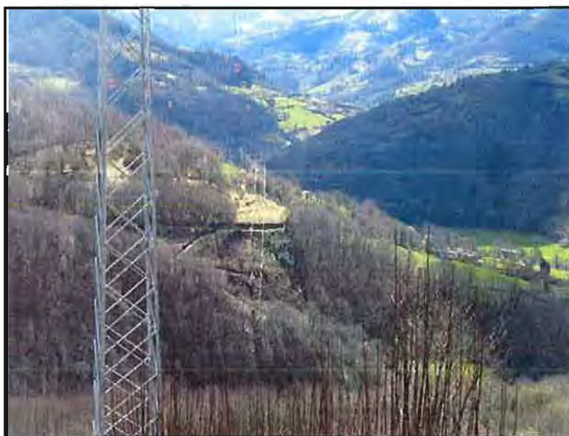
Conductor doble circuito con salvapájaros en el apoyo 19 (en la fotografía)
