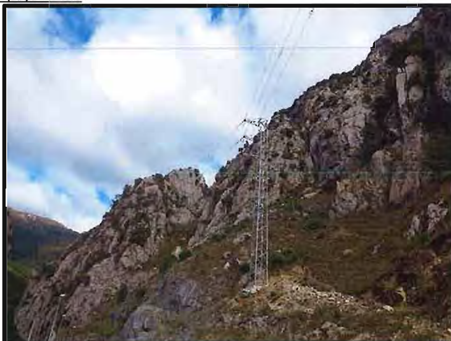
Acceso al apoyo n° 12:
