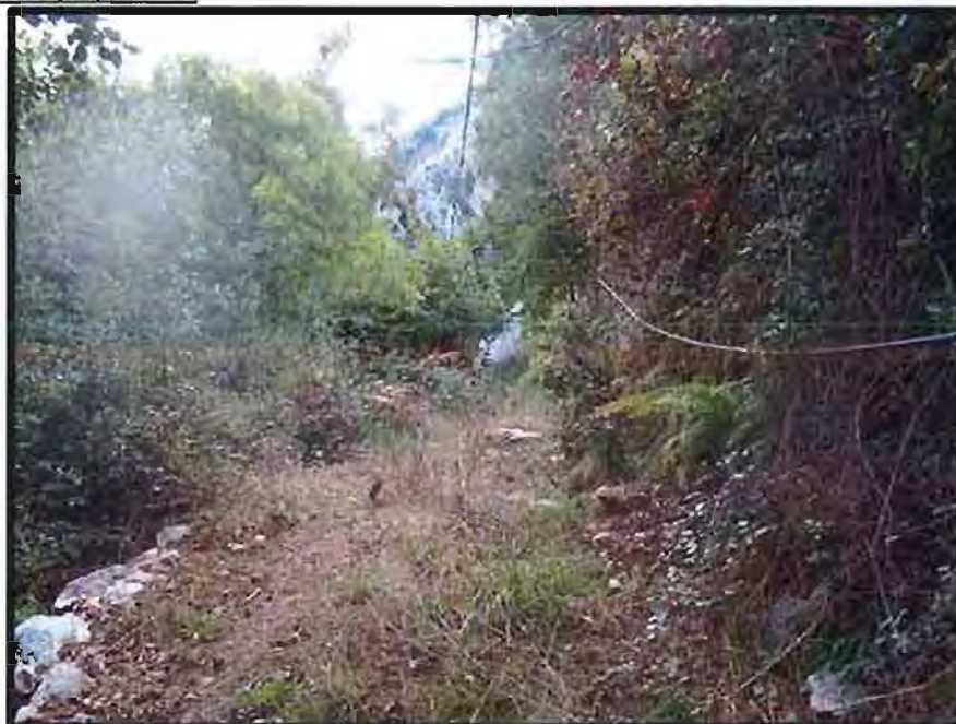
Acceso al apoyo nº 7:
