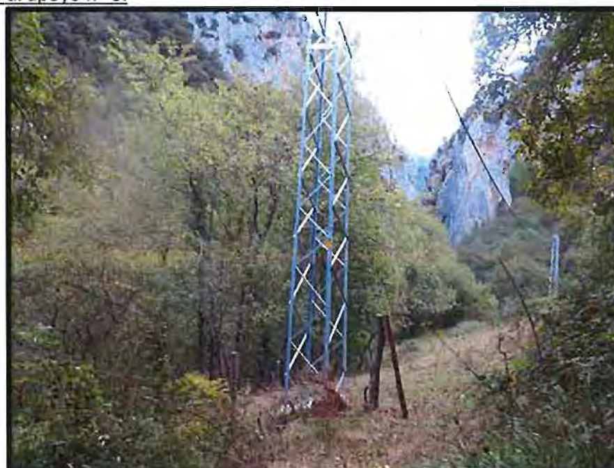
Acceso al apoyo nº 8:
