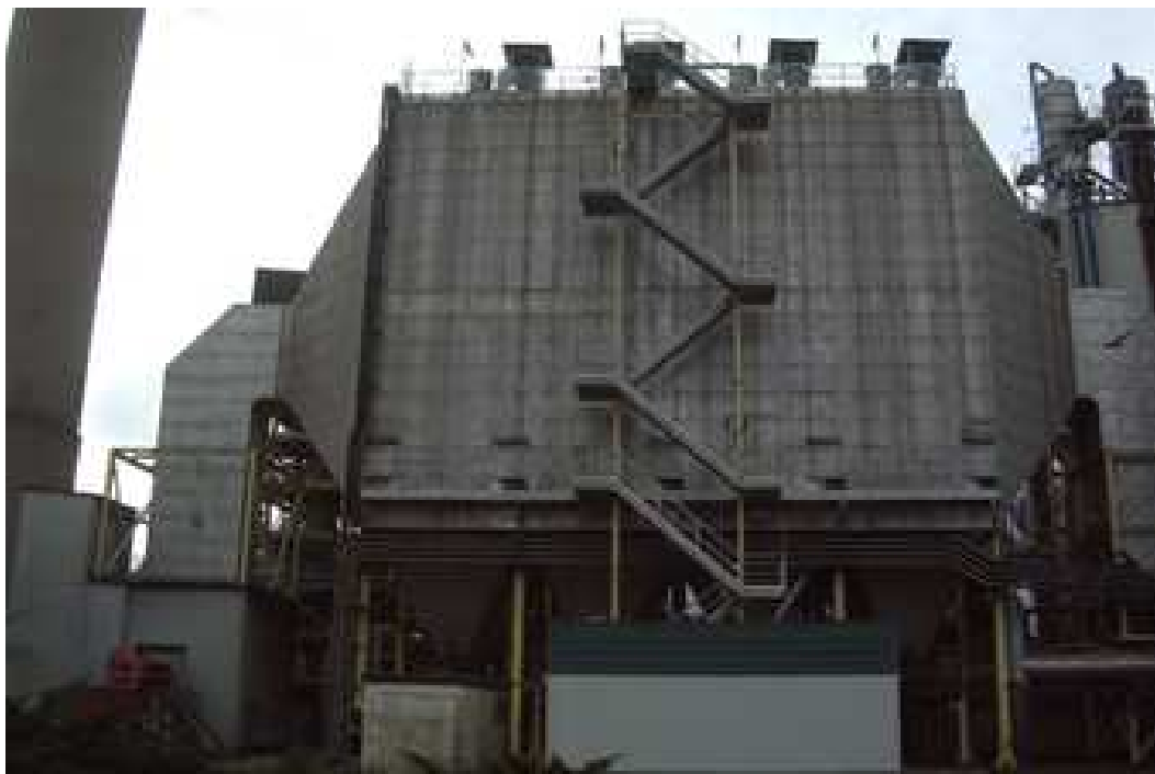
Detalle del electrofiltro actual, que será cambiado por un filtro de mangas.
