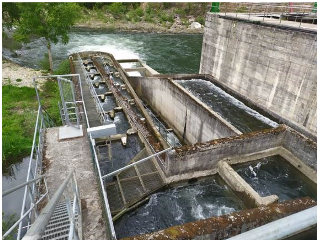
Imagen 7. Vista detalle de la rampa y la escala de peces.
