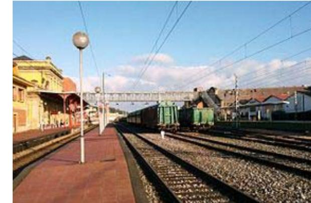
Consiste en una plataforma para seis vías, tres de ancho ibérico y tres de ancho métrico y tres andenes. Todas las vías terminan en fondo de saco junto al edificio de viajeros.
