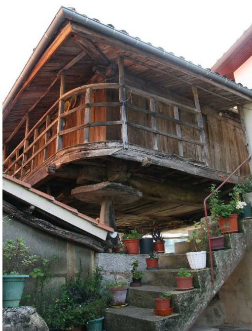
Hórreo fechado en 1797 rodeado de «elementos discordantes»: canalón de PVC, escalera de cemento con barandilla, caseta adosada, etc.
