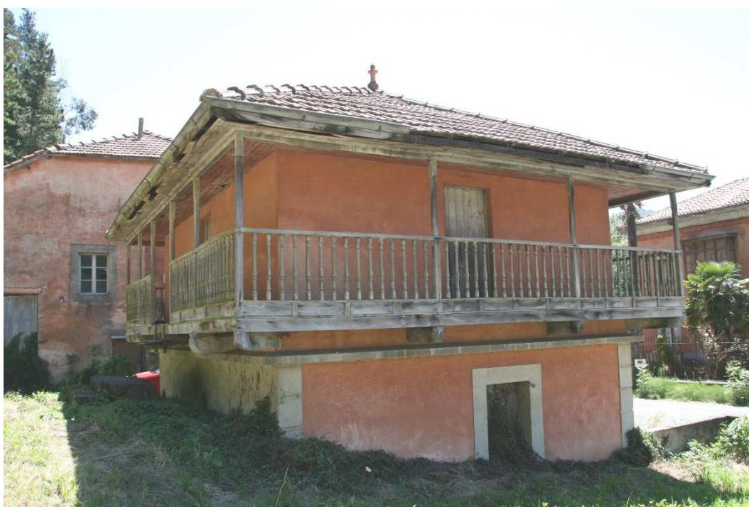
Granero con cámara de ladrillo revocado construido hacia 1900.
