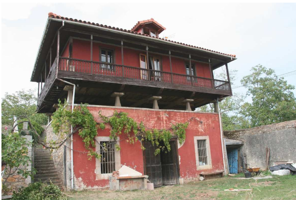
Panera construida hacia 1900 con cámara de ladrillo revocado y rehabilitada como vivienda.
