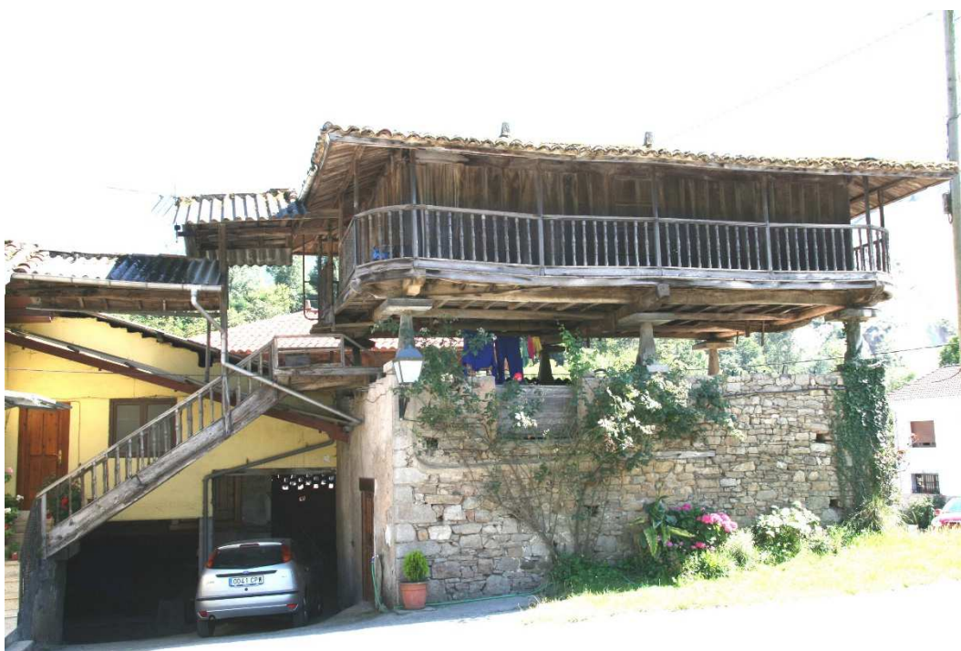
Panera fechada en 1894 con acceso mediante escalera de madera volada y cubierta.
