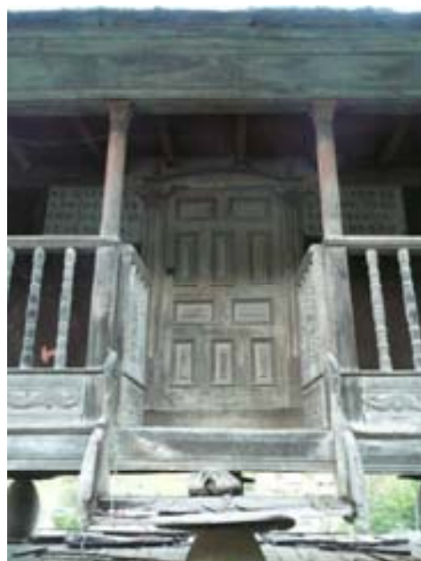
Arriba: Tornapolvo, cantenal, cancellos y puerta. Se aprecian las cartelas que indican las fechas de su armado y de su pintura.
