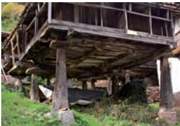
Dos hórreos en alineación en Cuevas, Miranda. El primero presenta suelo de pontes con dos sovigaños colgados con estribo de madera. A la derecha, hórreo de seis pegollos con bragueiru y suelo de tillu (pontones y tabla) en Isongu, Cangues d'Onís.
