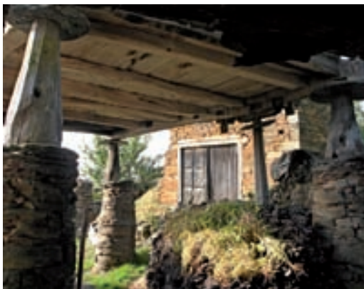
Suelo de cadenas y tabla en un hórreo de Uría, Ibias; una solución muy extendida en los hórreos occidentales. A la derecha, panera de dos crujías en el concejo de Miranda, con suelo de pontes, viga panera y sovigañu.
