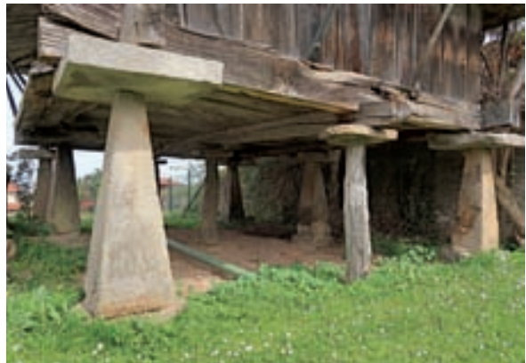
Solláu de pontes con sovigañu atado, añadido, en un hórreo del siglo XVI en Sama, Grau. A la derecha, panera en Caravia de fines del XVII con bragueiru y pegollu central definiendo dos crujías longitudinales.
