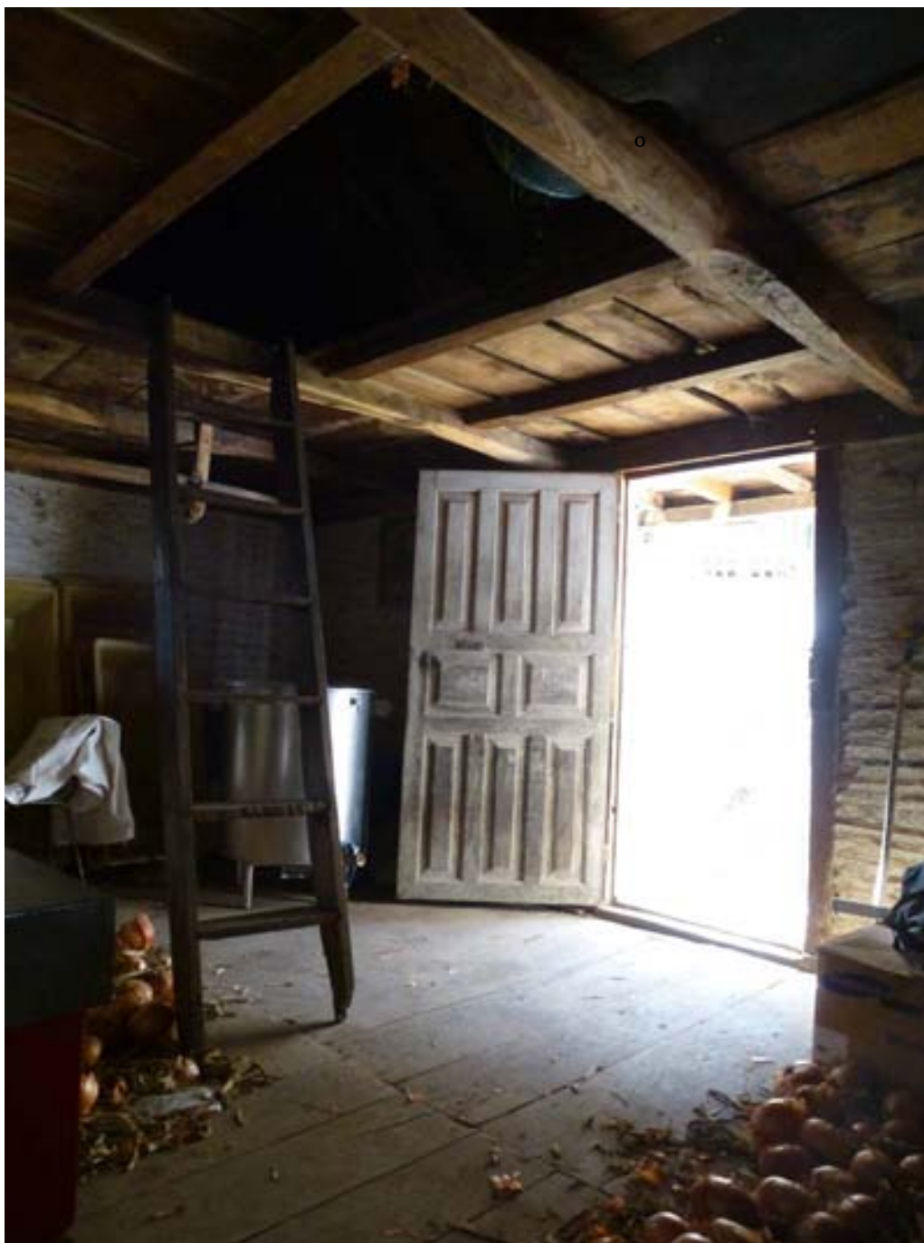
INTERIOR DE PANERA CON CORONDIA DE IMPRENTA. Casa Chope, L.lano, Cangas del Narcea. Se puede ver también el tillado del sombráu, al que se accede por una escalera de mano. Carpintero Pepe Menéndez, 1915.
