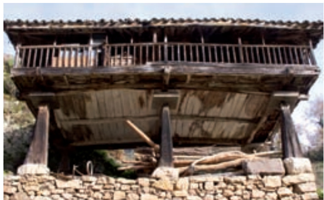
Suelo de cadenas y tabla en un hórreo de Uría, Ibias; una solución muy extendida en los hórreos occidentales. A la derecha, panera de dos crujías en el concejo de Miranda, con suelo de pontes, viga panera y sovigañu.
