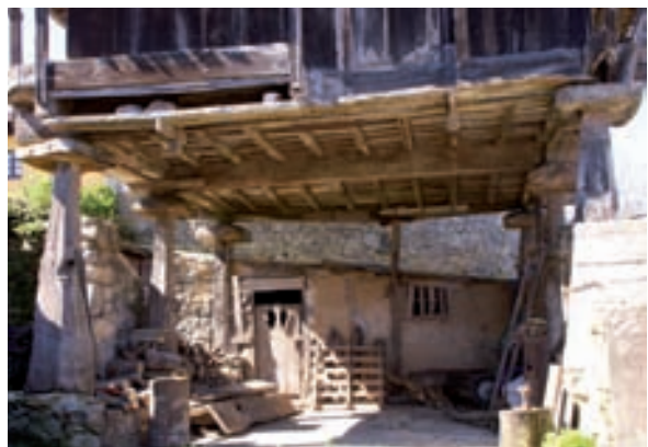
Dos hórreos en alineación en Cuevas, Miranda. El primero presenta suelo de pontes con dos sovigaños colgados con estribo de madera. A la derecha, hórreo de seis pegollos con bragueiru y suelo de tillu (pontones y tabla) en Isongu, Cangues d'Onís.
