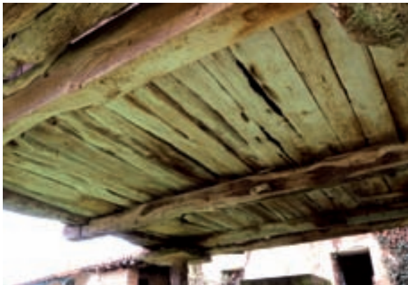
Solláu de pontes con sovigañu atado, añadido, en un hórreo del siglo XVI en Sama, Grau. A la derecha, panera en Caravia de fines del XVII con bragueiru y pegollu central definiendo dos crujías longitudinales.
