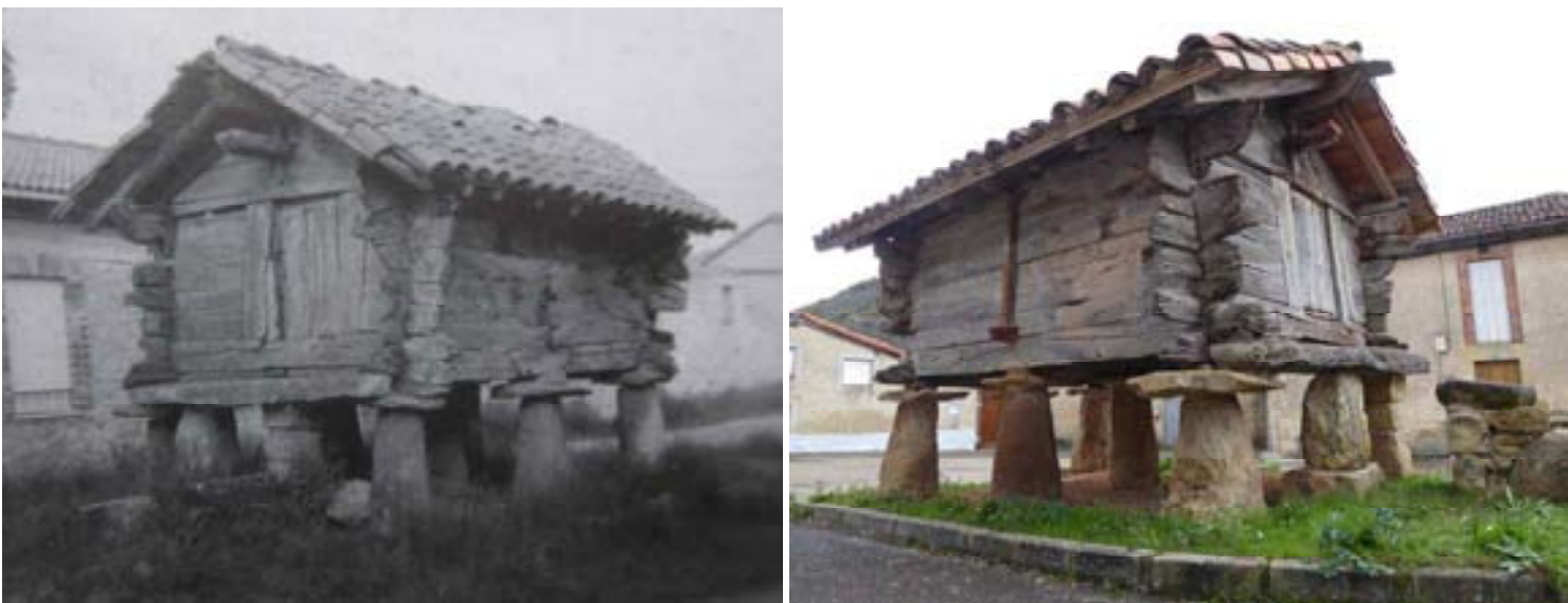
A la izquierda, el hórreo antes de su restauración de 2011. A la derecha una imagen reciente.
