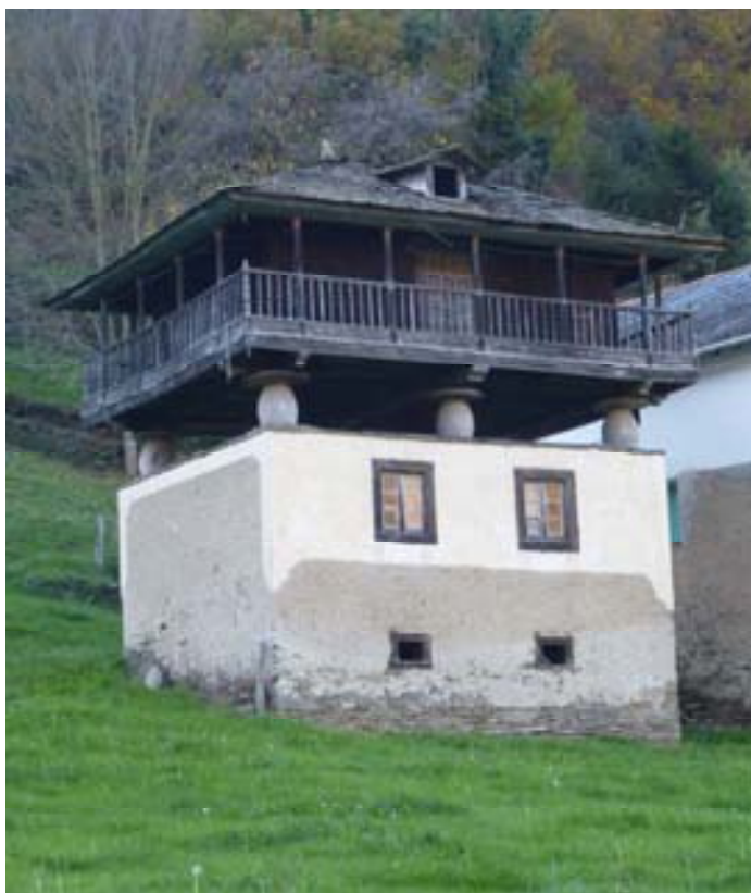
A la izquierda, vista de la misma panera. Se aprecia una bodega y encima el “cuarto de la panera” que conforman el podio. El tornapolvo es el espacio delimitado por los pegollos.
