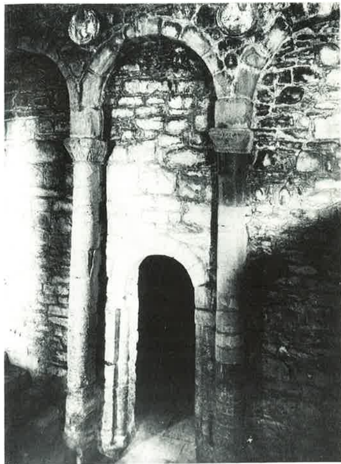
Lám. 6. Paramento mural compuesto: arcadas ciegas. Puerta de acceso a cámara lateral.
