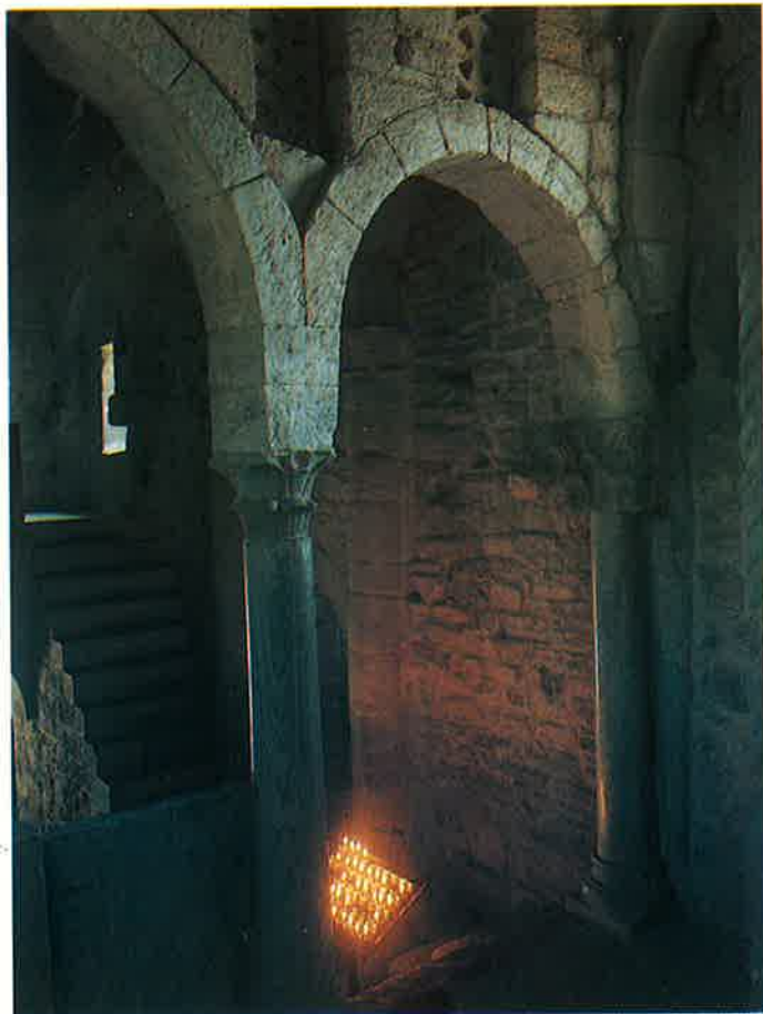
Lám. 13. Detalle del iconostasis: columnas monolíticas, capiteles corintios, arcos peraltados y celosías.
