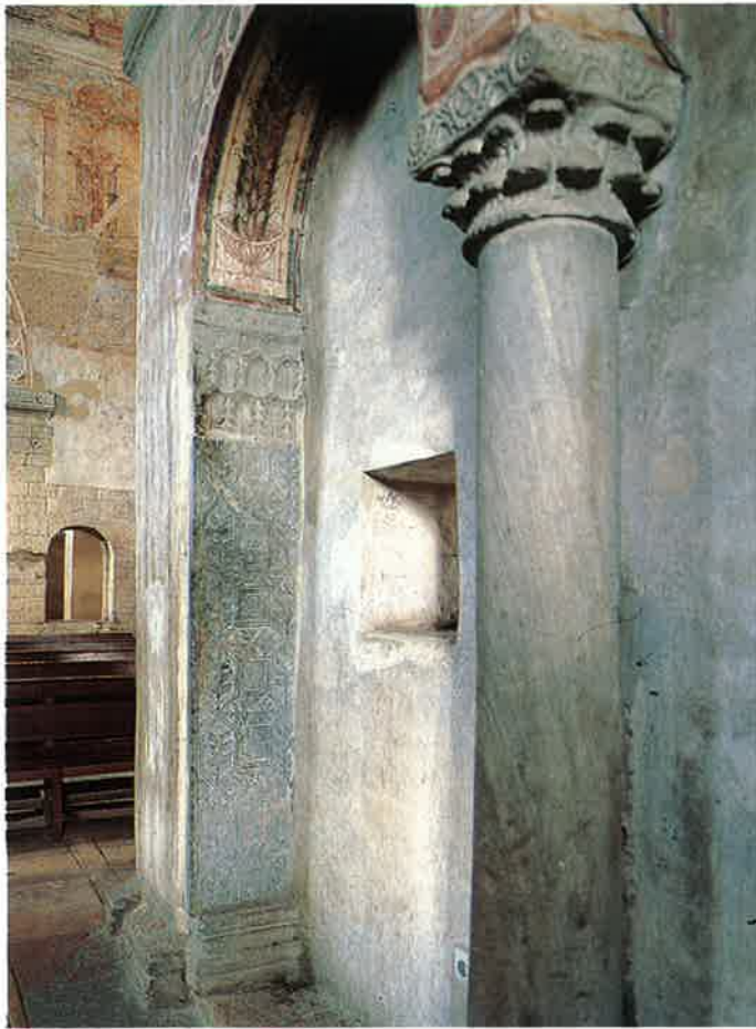
San Julián de los Prados. Detalle del ábside mayor.
