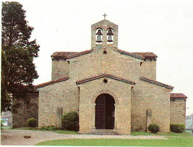
San Julián de los Prados. Fachada.
