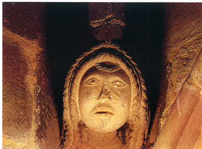
Fig. 14. Ménsula de arranque de uno de los nervios cruceros.
