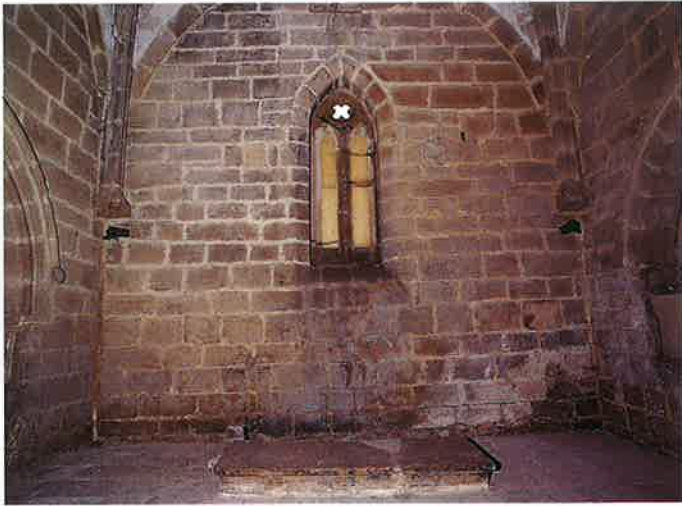
Fig. 11. Muro testero, con la única ventana del edificio..
