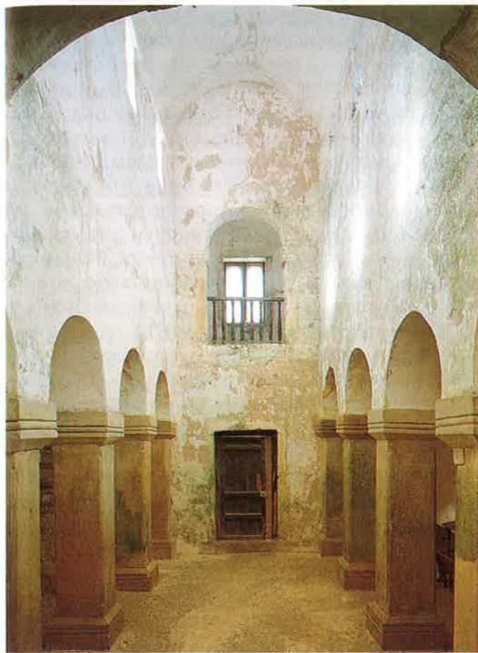
Interior de Valdediós desde el ábside.
