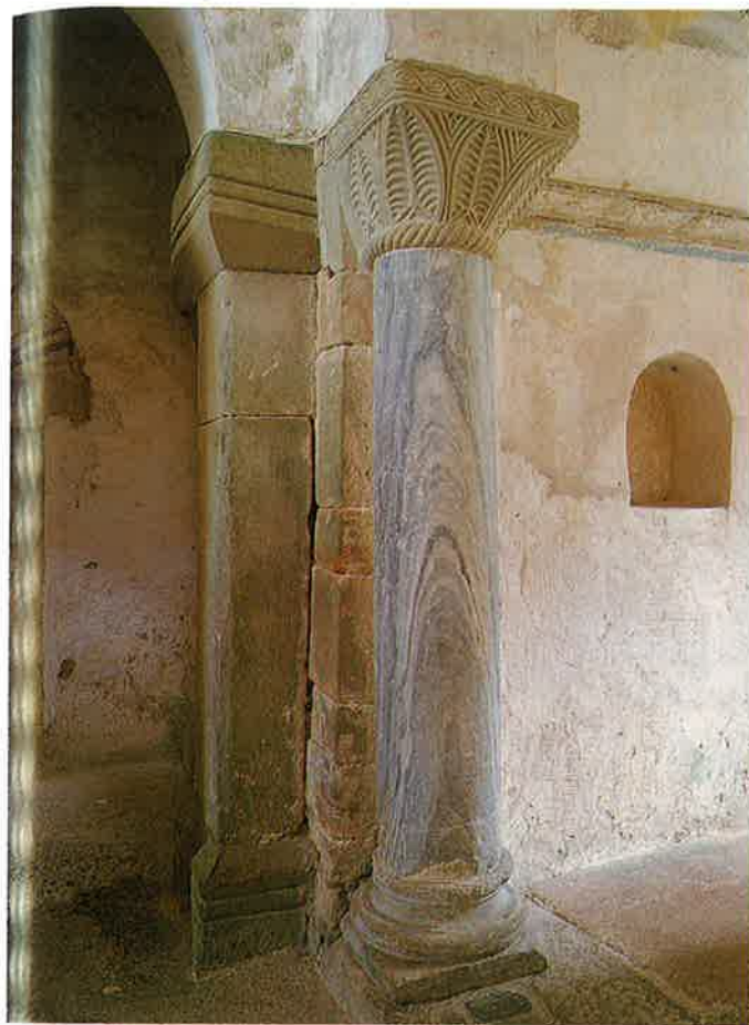
Columna de acceso al ábside central.
