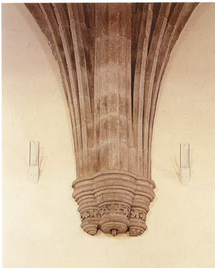
Ménsulas del tramo medio de la nave.
