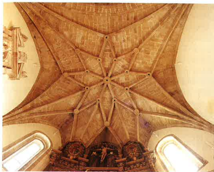
Bóveda de la Capilla mayor
