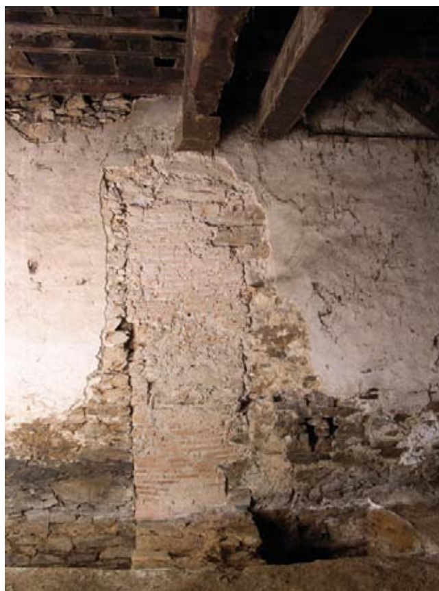
Ampliación de la habitación D hacia el sur: Relleno con ladrillo del hueco originado por el arrasamiento del muro 4-5. Además se aprecia la doble viga de refuerzo en el forjado del primer piso.
