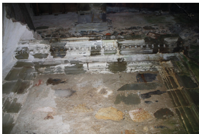
Puerta de acceso desde el claustro renacentista al templo, cegada con la reforma neoclásica.
