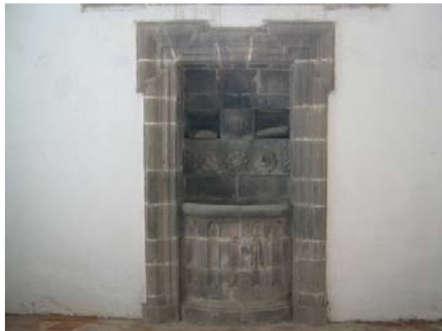
Lavamanos localizado en la antesacristía.
