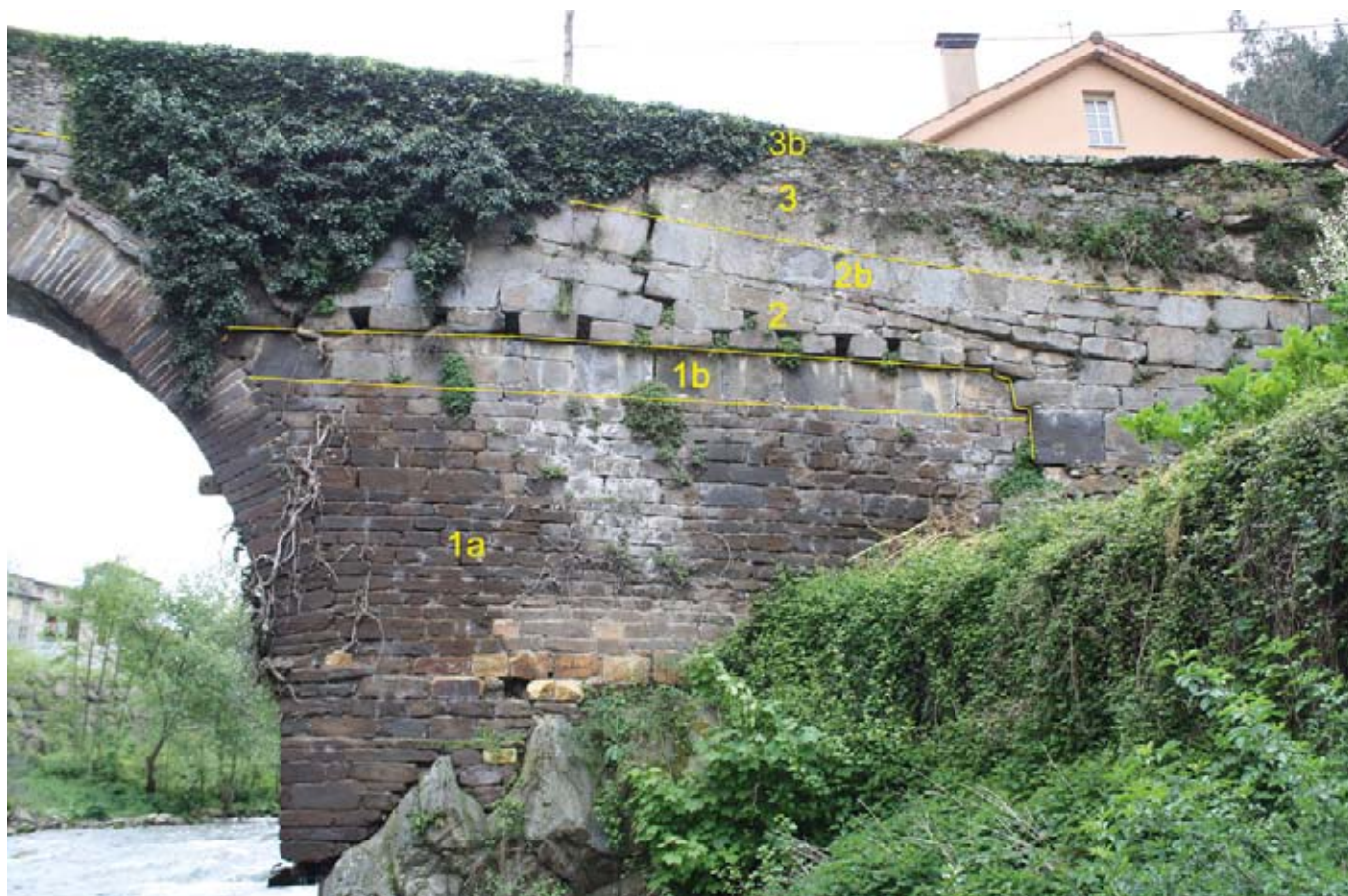
Cuerpos de fábrica que se aprecian en el muro de acompañamiento norte.
