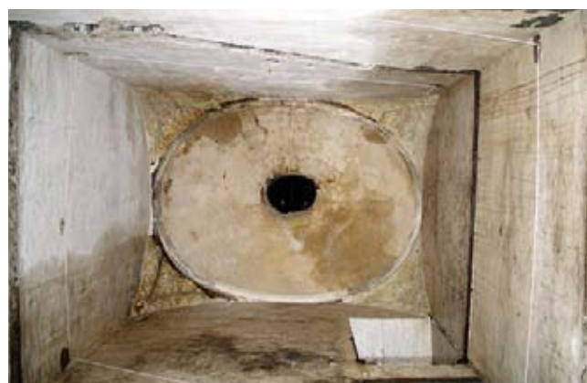
Vista inferior de la cúpula elipsoidal que cubre la caja de la escalera.
