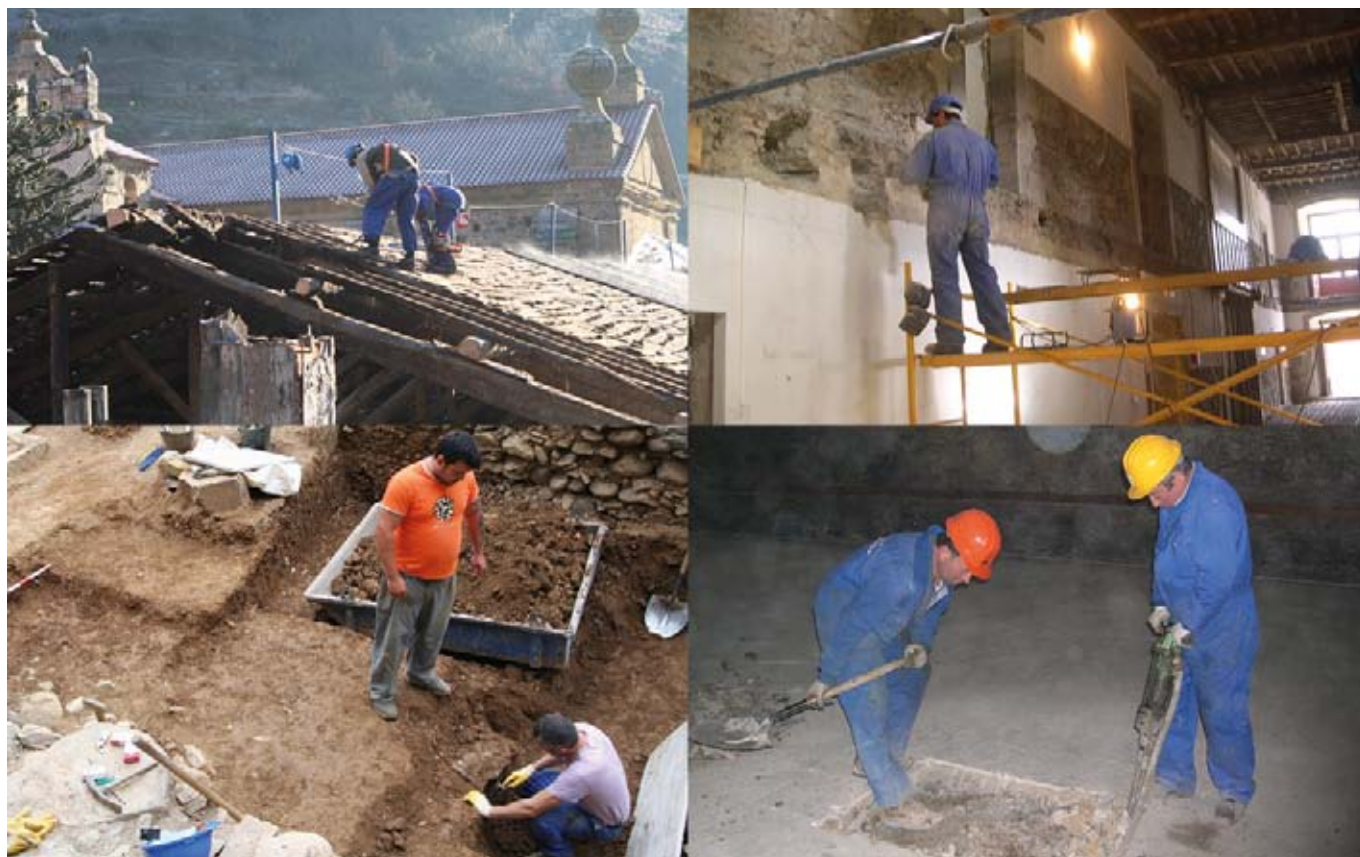
Obreros en el tajo. Su colaboración fue determinante a la hora de identificar y documentar un considerable número de detalles constructivos ocultos en el edificio.
