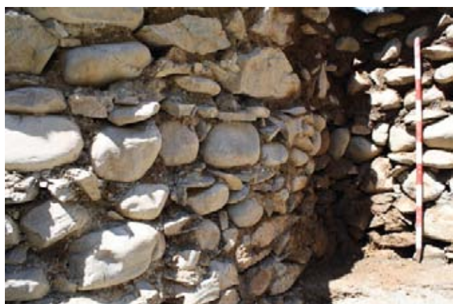
Morfología de la fábrica del cimiento del ábside sur.
