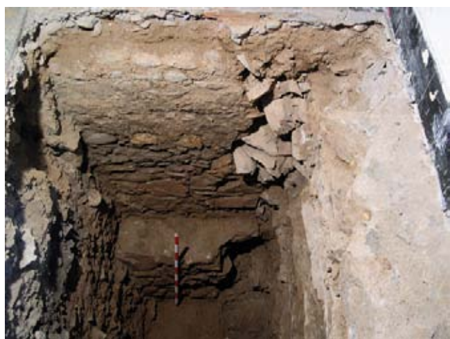
Cimiento (UE 3-9) del cerramiento oeste de la panda oriental del patio barroco.
