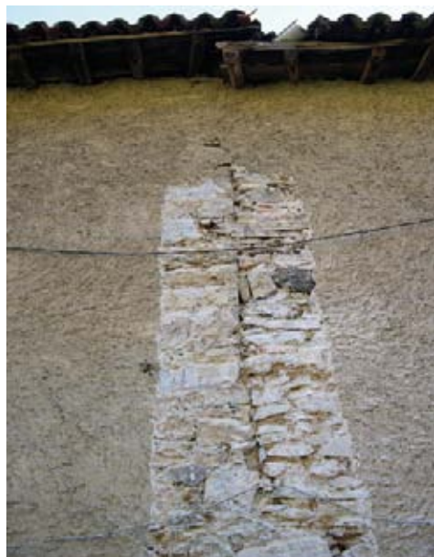
Adosamiento y recrecido en altura de la habitación E, adosada al primer piso de la habitación G.
