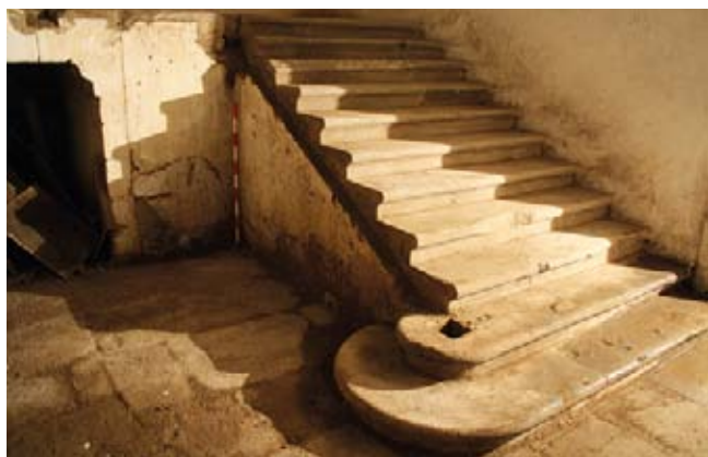
Podio de cantería de la escalera de la sacristía.
