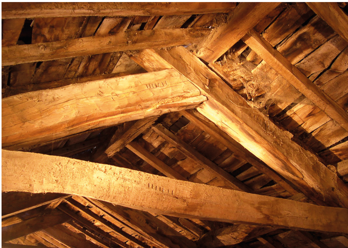
Detalle del tramo superior de la cercha tipo 3. Se aprecian las marcas de montaje (en este caso siete rayas incisas paralelas y verticales) en las dos pares y en la viga puente.
