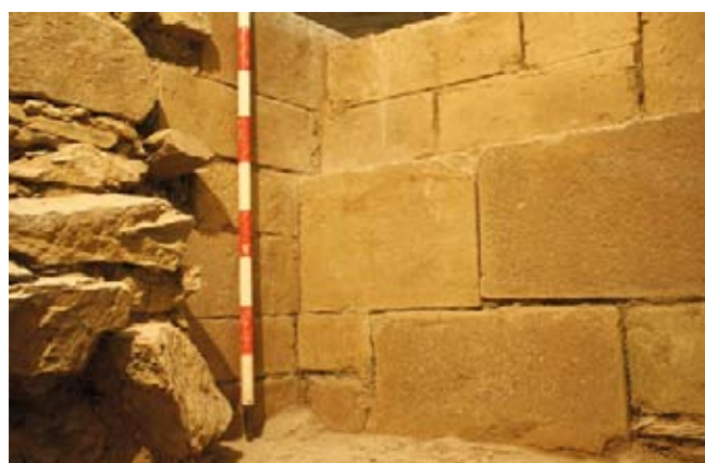
Fábrica de sillería conservada en el paramento exterior occidental del transepto sur.
