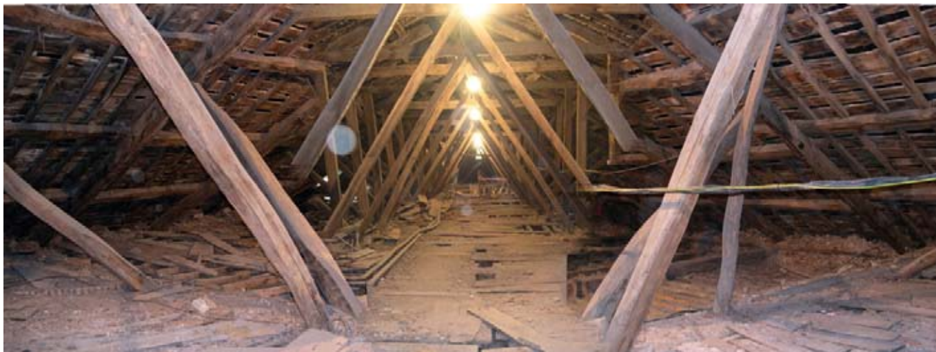
Vista general del bajocubierta en la panda oriental del monasterio neoclásico, donde se localizan las cerchas de mayores dimensiones (n.º 2) que permiten utilizar este espacio como despensa y almacén.
