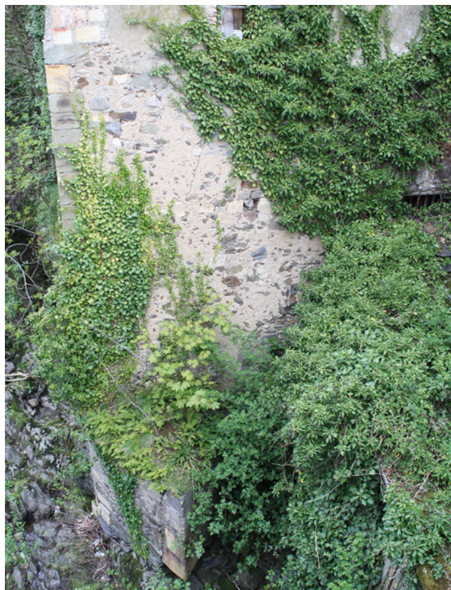
En la fotografía se aprecia el tajamar construido en la base del muro oeste.
