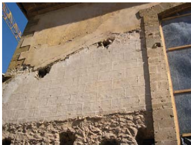
Detalle del exterior del testero del ábside, donde se aprecia la fábrica de mampostería de los cerramientos, reservándose la cantería de arenisca para esquinales y cornisas.
