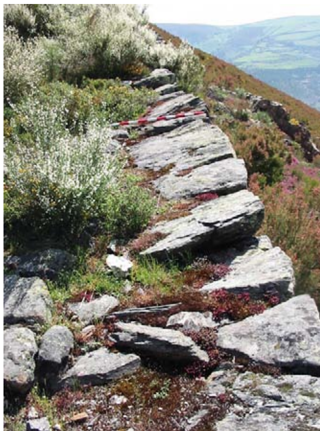
Murete de contención del borde exterior del camino de acceso a la cantera de Peña Mayor.
