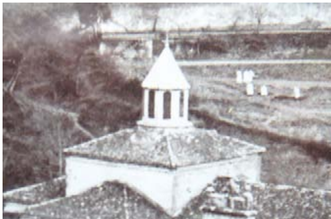
Vista de la linterna de la cúpula de la iglesia a principios del siglo XX, antes de que fuera sustituida por la actual en 1960.
