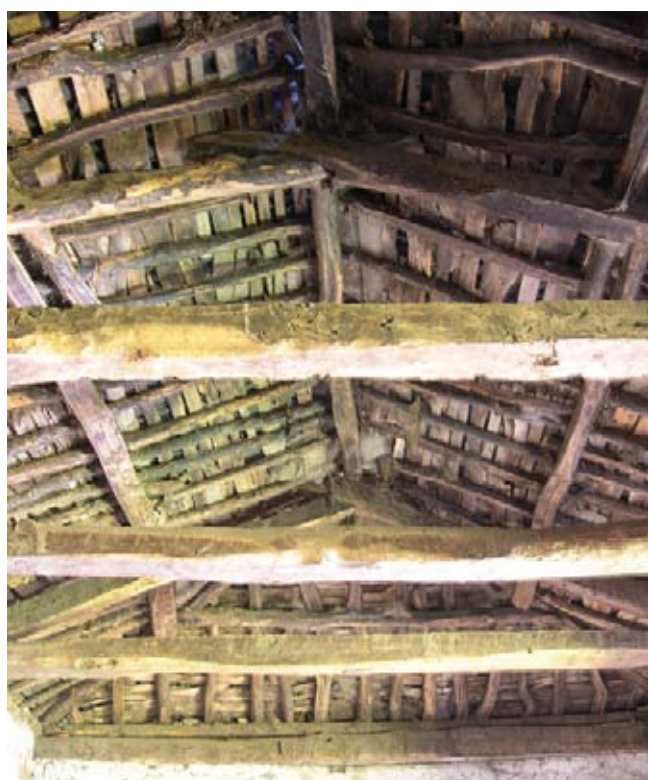
Estructura de la cubierta de la habitación A. Esta armadura originaria está constituida por tres pares de tijeras entre las que se intercalan dos vigas madre sencillas al mismo nivel. Las tijeras engarzan por encaje a media madera. Las vigas madre tercera y cuarta en sentido hacia el este están reutilizadas de un forjado anterior, como acusan las marcas de encajar pontones.
