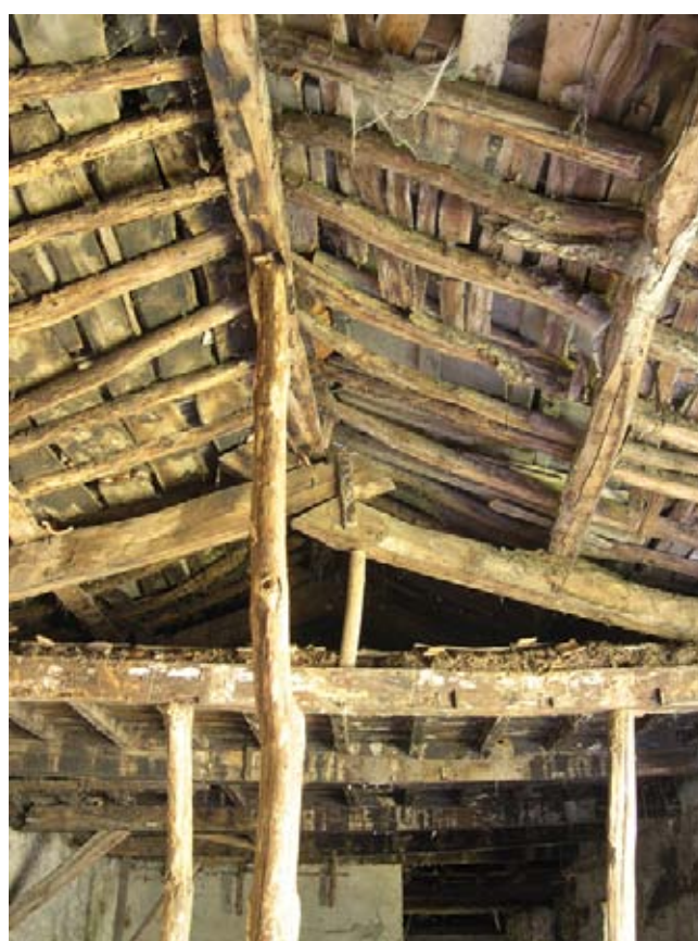
Estructura de la cubierta de las habitaciones G y H. Se aprecian tipologías diferentes y varias reformas.
