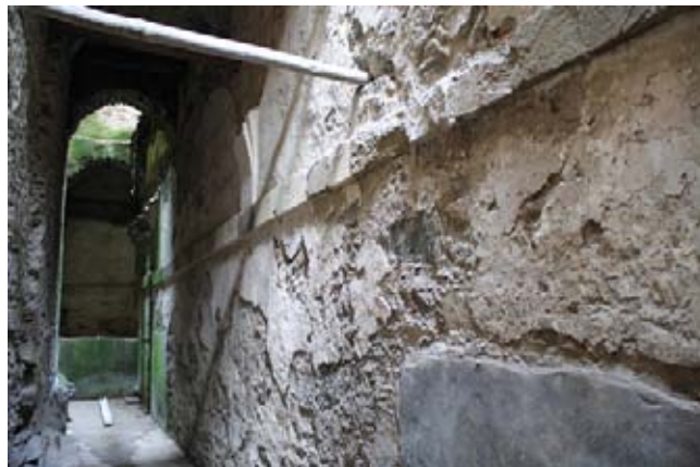
Pasadizo del osario del monasterio neoclásico. En el alzado norte del templo se conservan las trazas de la crujía abovedada del claustro renacentista.
