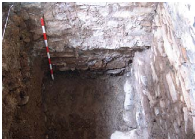
Sector 12: Vista de la zapata de cimentación 12-5 sobre la que se levanta la pared maestra 12-4, a la que adosa el podio del corredor (12-6). Estas estructuras buscan la superficie de la roca base (UE 12-3) para su cimentación.
