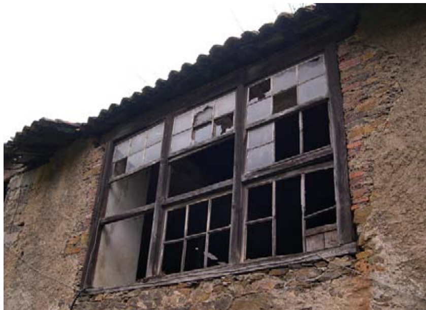
Rotura del cerramiento norte de la habitación G a la altura del primer piso para instalar una ventana cristalera de grandes dimensiones. Recercado de ladrillo macizo.
