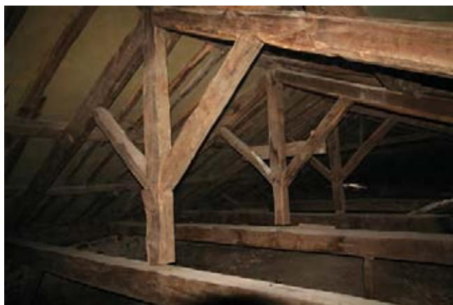
Cerchas originales de la cubierta de la nave de la iglesia renacentista.
