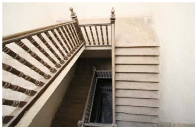
Estructura de madera de la escalera.
