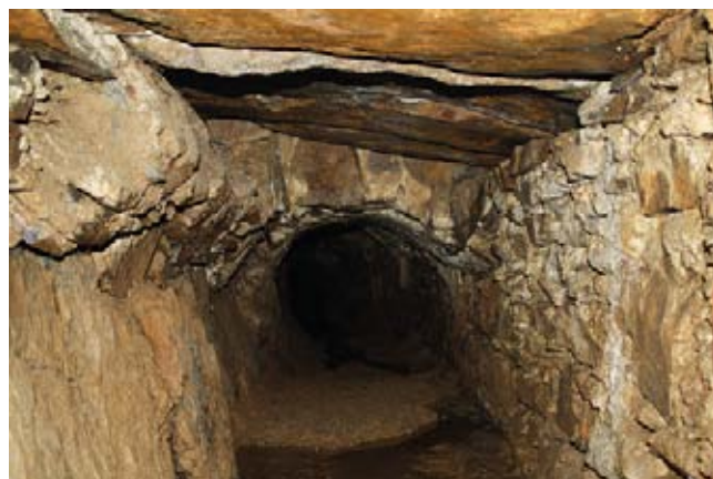
Tramo inicial de la alcantarilla, bajo el obrador de la botica neoclásica. Combina un tramo cubierto con losas con otro abovedado.
