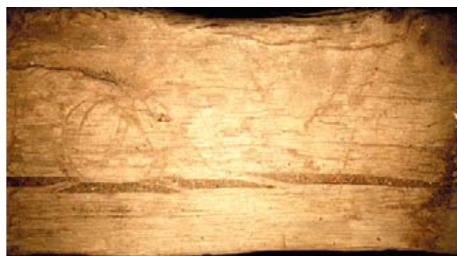
Marcas de carpintero (dos círculos secantes) localizadas en una de las vigas.
