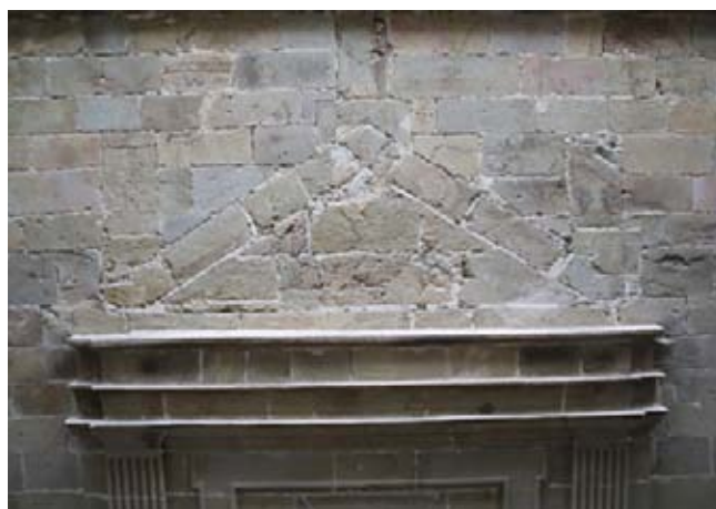
Frontón triangular que remataba el piso superior de la portada y que fue picado con la reforma neoclásica.
