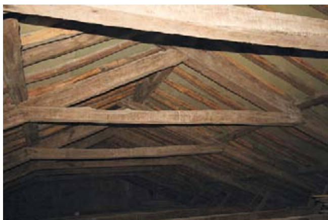
Cerchas reformadas, seguramente durante la obra neoclásica.
