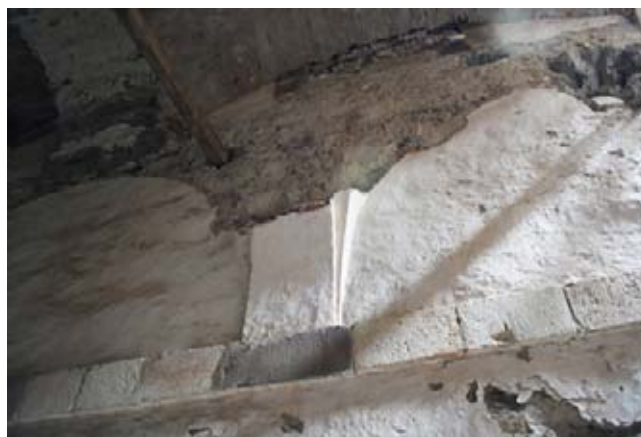
Detalle del arranque de uno de los arcos fajones que separa los tramos abovedados de la crujía, y que se apoya sobre la línea de imposta.
