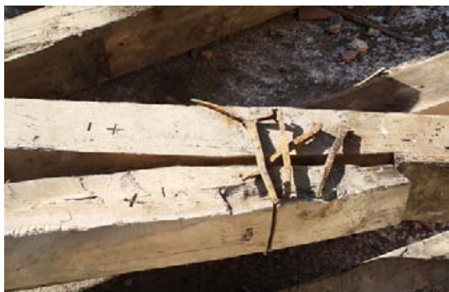
En la fotografía se aprecian las marcas de ensamblaje (una línea y un aspa) que vinculan la viga tirante con su correspondiente viga par. También aparecen los grandes clavos de hierro empleados en el ensamblaje de las vigas.
