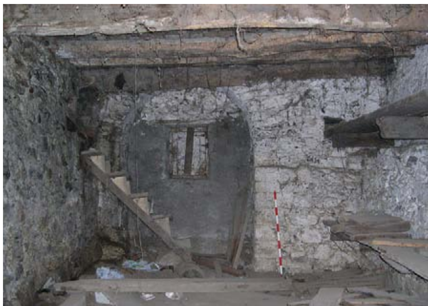
El infierno del molino. A la izquierda se observa el arco de medio punto abierto en el muro oeste (aguas arriba), que se corresponde con el tajamar adosado al exterior.
