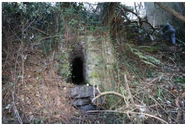
Boca de desagüe de la alcantarilla central, situada a cierta distancia y por encima del cauce del río.
