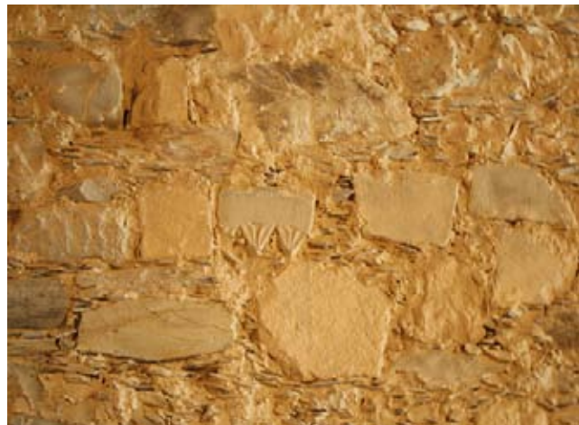
Materiales modernos y medievales reaprovechados en la fábrica neoclásica.
