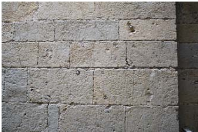
Fábrica de sillería de la fachada del templo renacentista.
