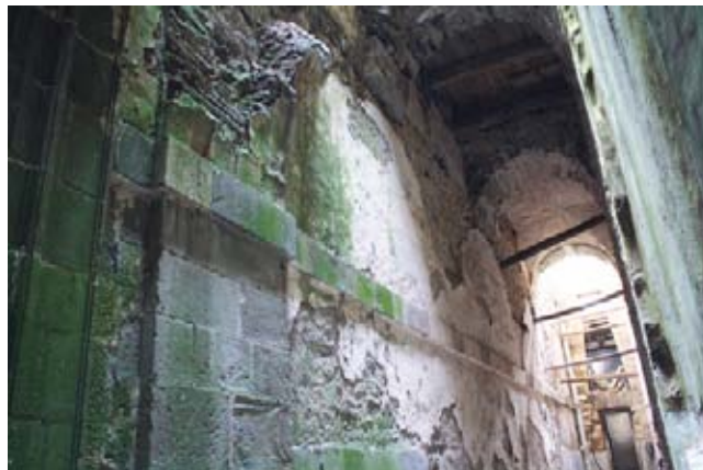
Pilastra situada a la derecha de la puerta renacentista y que marca el arranque de los tramos abovedados de la crujía sur del claustro renacentista.
