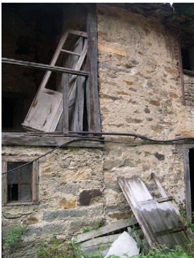
Adosamiento del corredor a la esquina suroeste de la habitación D.
