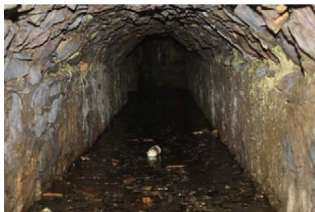
Tramo abovedado de la alcantarilla que recorre el subsuelo de la botica neoclásica.
