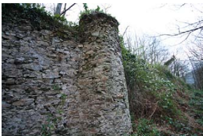
Tramos de la cerca situados en el flanco meridional.
