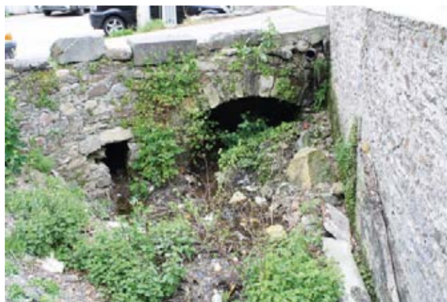
El Pontigo. Pequeño puente con fábrica de mampostería situado delante de la fachada del monasterio que salva el curso del reguero de Vallinas. A su izquierda se aprecia el desagüe de la alcantarilla.
