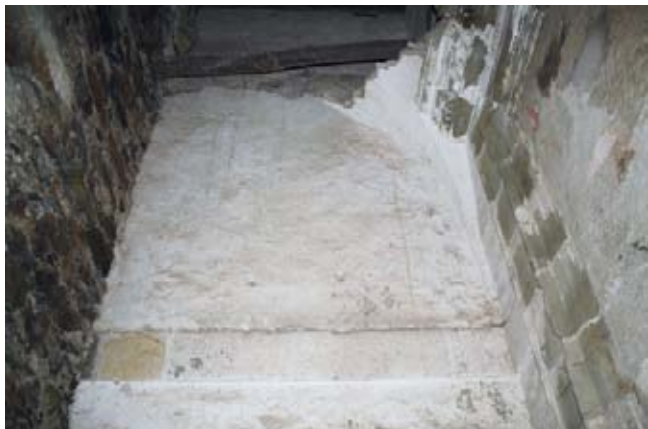
Arranque de la crujía este del claustro renacentista. A la izquierda de la fotografía se aprecia cómo está cortada por la obra del monasterio neoclásico.
