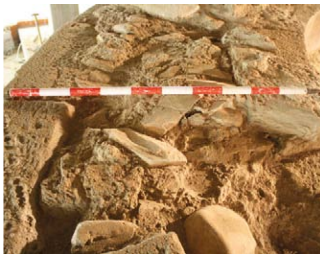
Vista de la fábrica del cerramiento del ábside sur. Presenta un paramento exterior y otro interior de sillería, y un relleno interior de mampuestos y mortero.
