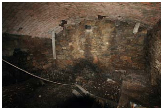
Pozo negro en el subsuelo del monasterio neoclásico.
