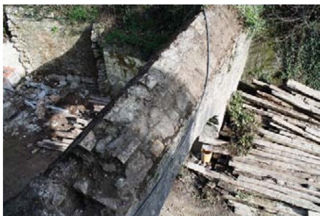
Acueducto por el que penetra la conducción de agua potable en la cilla y la cocina del monasterio.
