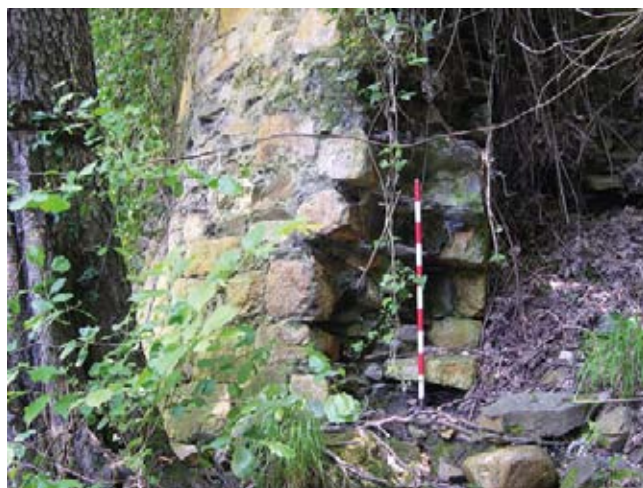
Vestigios del cubo de la esquina de la cerca situado junto al molino.
