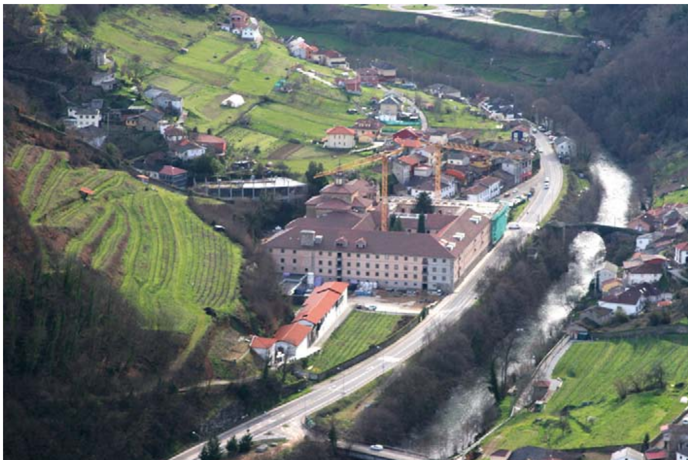
Vista del Monasterio en la que se aprecia la ladera de viñedos contigua al monasterio, situada por encima del nivel de la cubierta del edificio, poniendo de manifiesto la modificación del relieve natural de esa ladera, y como el edificio está encajado contra ella.
