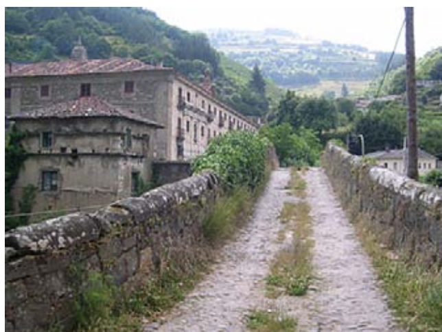
Vista del tablero empedrado y los pretiles del puente.
