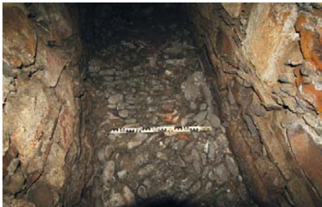
Detalle del pavimento empedrado del suelo de la alcantarilla central.
