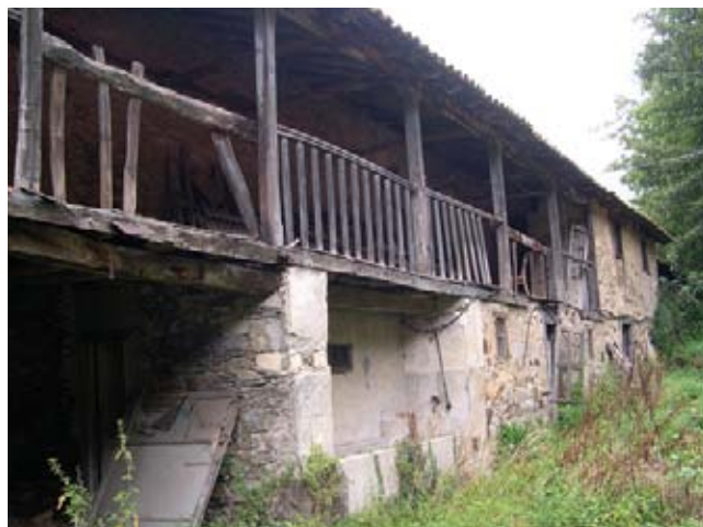
Vista del corredor de madera adosado a la estructura principal del edificio y abierto al patio posterior.
