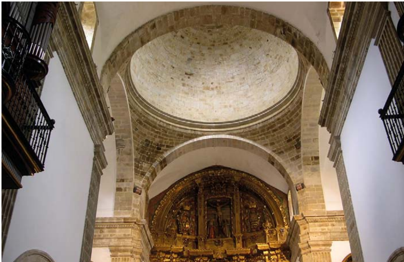
Vista de la gran cúpula sobre pechinas que cubre el crucero. Alcanza los 10,54 m de diámetro.
