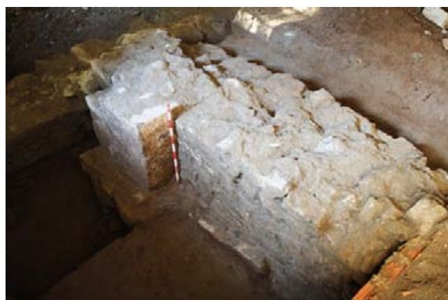
Cimiento y arranque de muro documentado en el sector 8, que se corresponde con el cerramiento exterior de la panda oriental del patio barroco.
