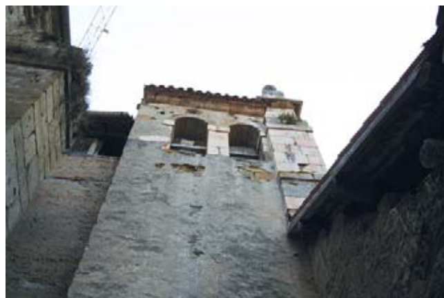
Tramo superior de la torre campanario.
