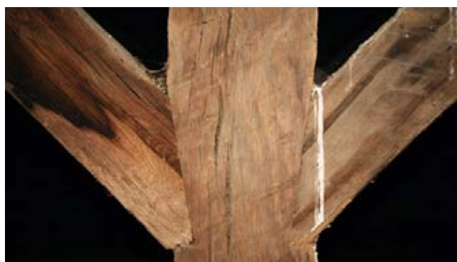
Detalles del ensamblaje de las cerchas renacentistas.
