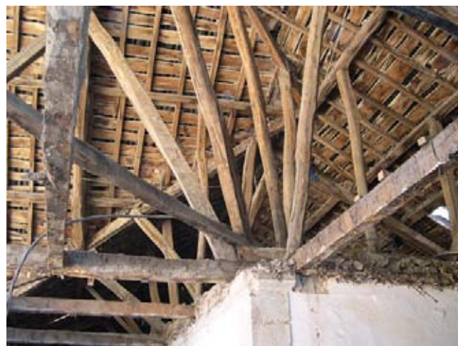
Multiplicación de pies derechos y tornapuntas en las esquinas para soportar el tejado.
