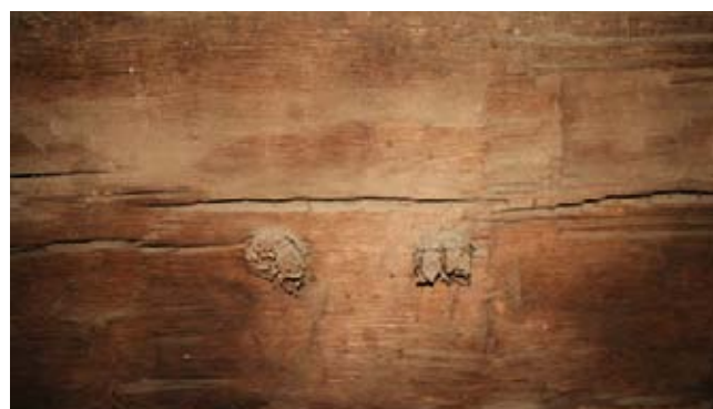
Pasadores de madera localizados en una de las vigas tirantes.
