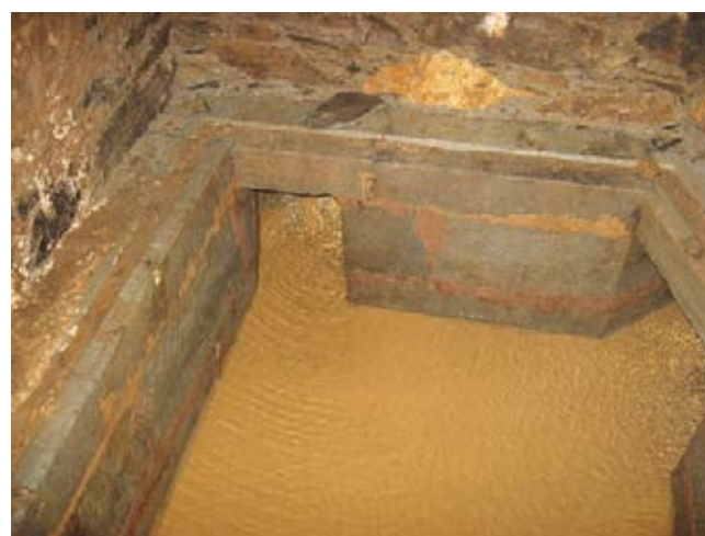
Interior del aljibe.
