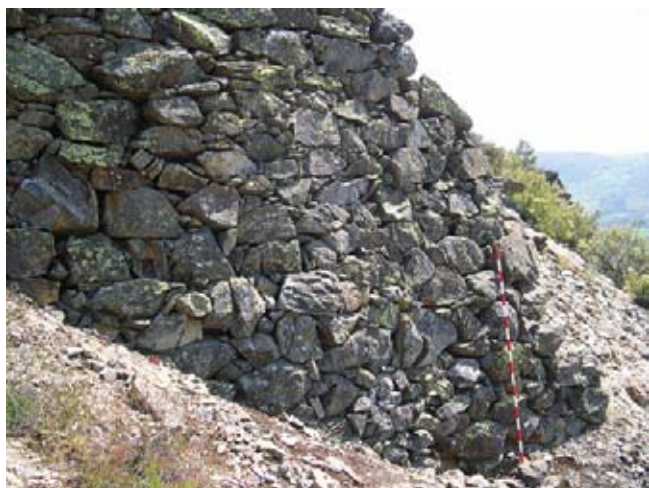
Detalle de la fábrica del lienzo de muralla.
