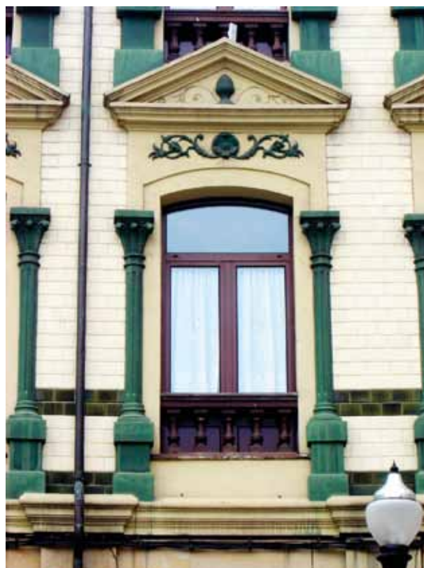
FIGURA 177: Detalle de la fachada.
