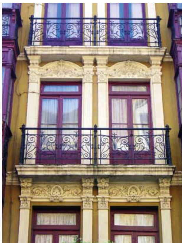
FIGURA 356: Detalle de fachada.
