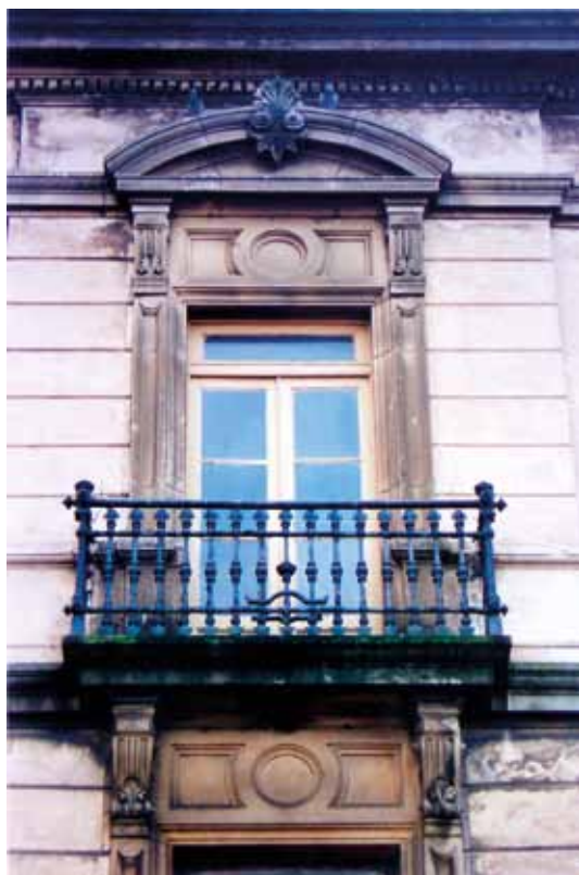
FIGURA 188: Detalle de la fachada.
