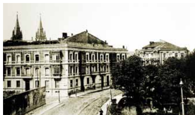
FIGURA 342: Estado del edificio hacia 1905.
