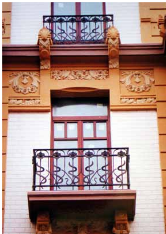
FIGURA 437: Detalle de la fachada.
