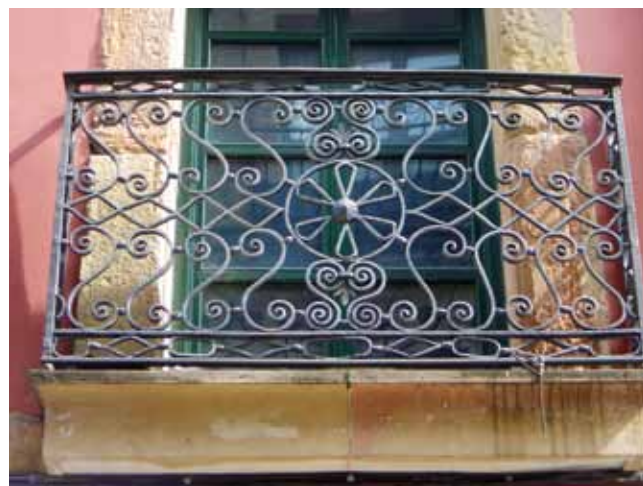
FIGURA 407: Detalle de la fachada.
