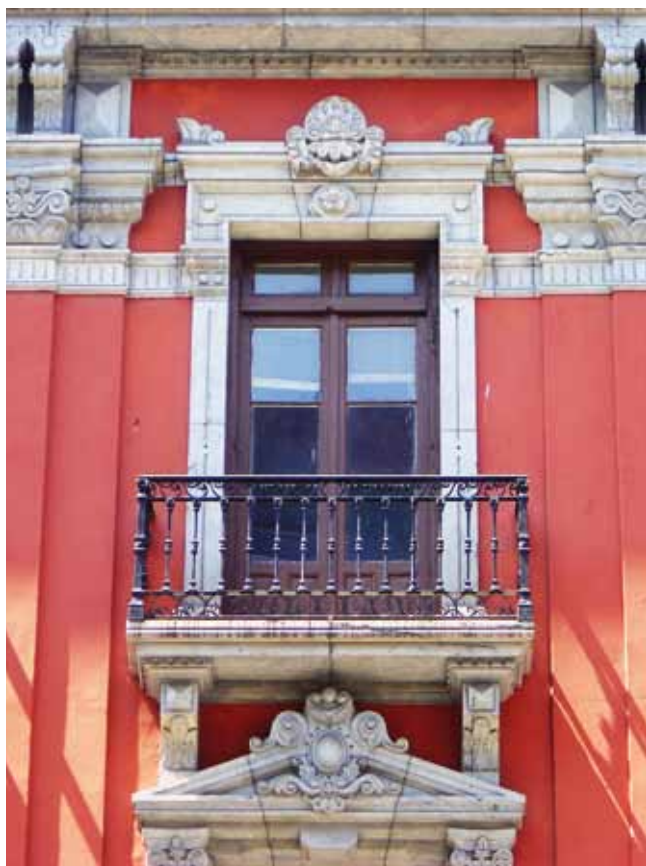
FIGURA 414: Detalle de la fachada.
