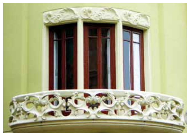
FIGURA 142: Detalle del balcón de la rotonda.
