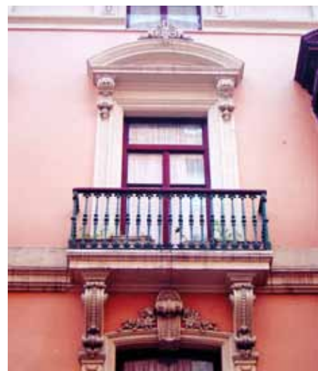
FIGURA 181: Detalle de la fachada.
