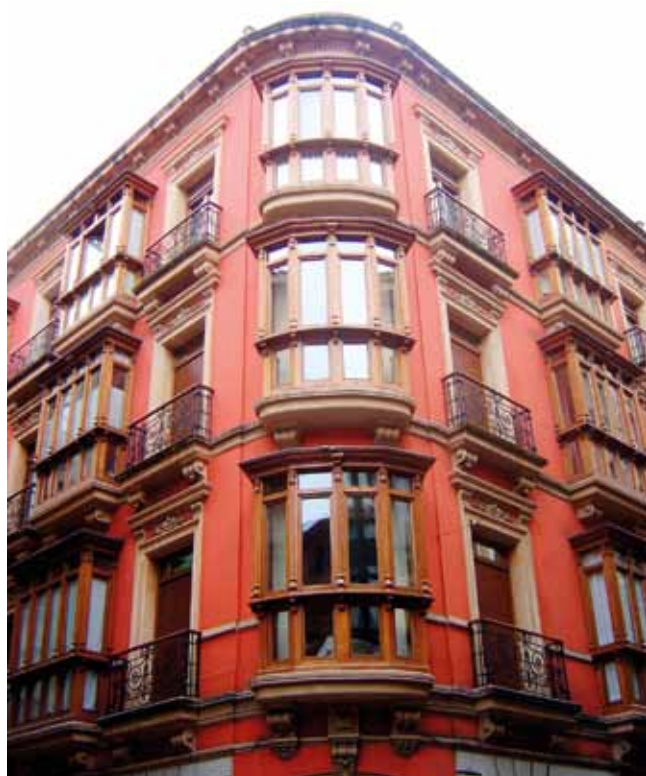
FIGURA 193: Detalle de la fachada.
