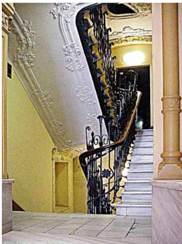
FIGURA 363: Detalle de la escalera.
