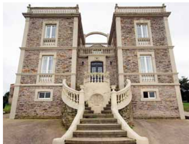
FIGURA 25: Villa Auristela, Villapedre (Navia). Estado actual.
