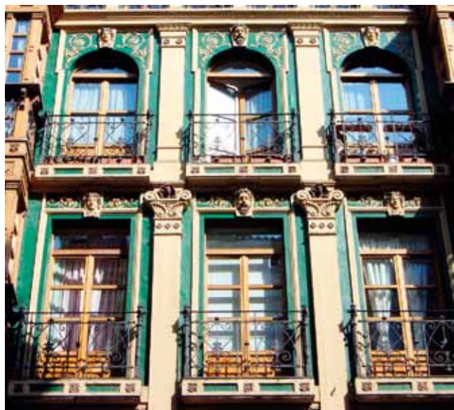
FIGURA 210: Detalle de la fachada.
