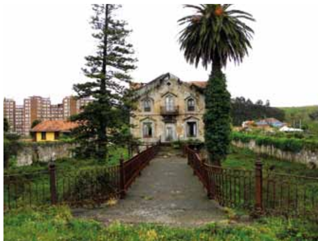
FIGURA 11: Chalé El Puente. Estado actual.
