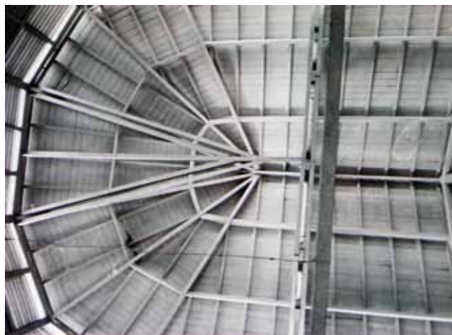
FIGURA 308: Detalle de la estructura de la cubierta.
