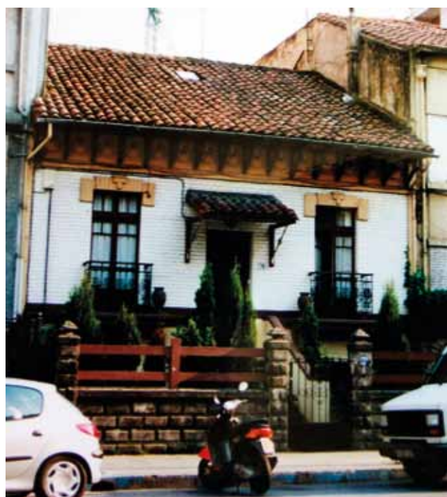
FIGURA 483: Vivienda unifamiliar económica en la avenida de Pablo Iglesias, Gijón. (D)
