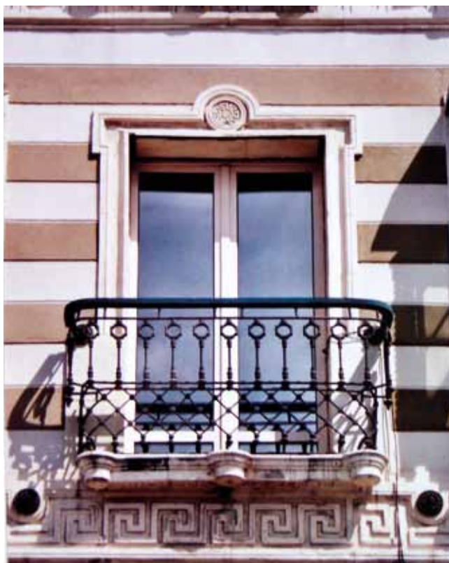
FIGURA 159: Detalle de la fachada.
