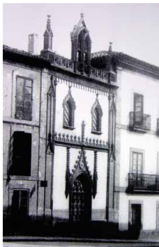
FIGURA 320: Capilla de Los Remedios, Cimadevilla, Gijón. (R)
