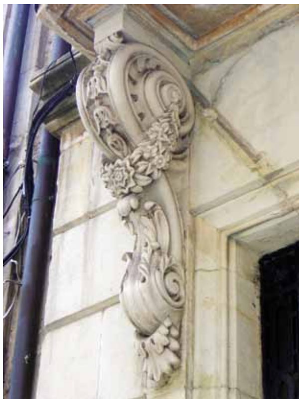
FIGURA 282: Detalle de la fachada.
