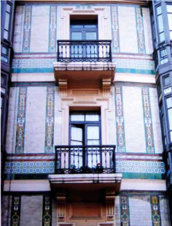
FIGURA 457: Detalle de la fachada.
