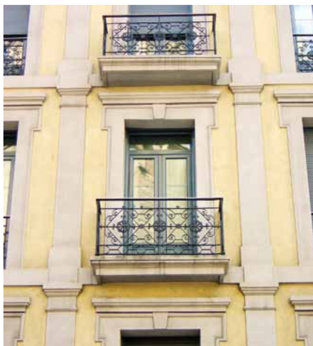
FIGURA 338: Detalle de la fachada.
