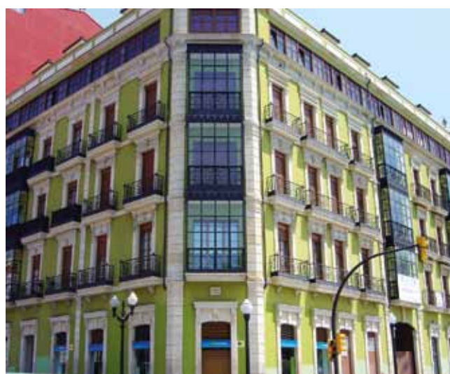
FIGURA 250: Estado actual del primer edificio.
