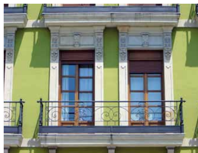
FIGURA 251: Detalle de la fachada.
