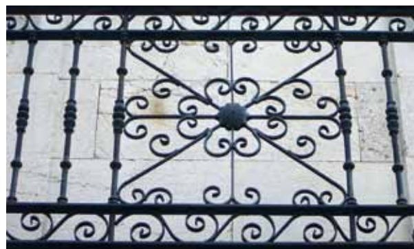
FIGURA 165: Detalle de la rejería del balcón.
