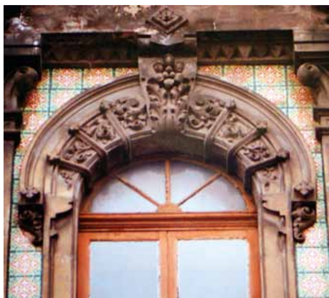
FIGURA 212: Detalle de la fachada.
