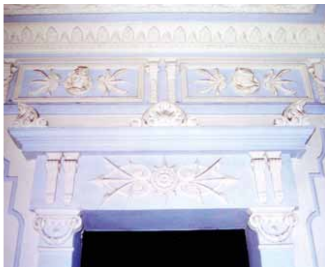
FIGURA 201: Detalle del vestíbulo del portal.
