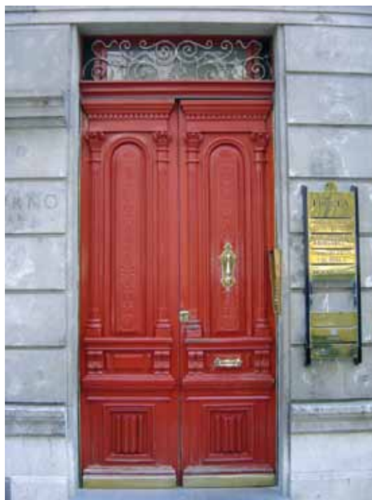
FIGURA 347: Puerta del portal.
