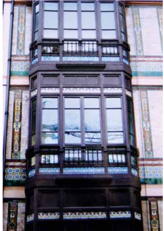
FIGURA 458: Detalle de la fachada.
