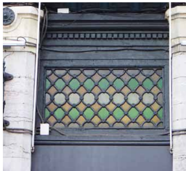
FIGURA 161: Detalle de la fachada.
