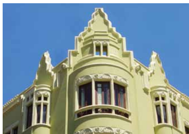
FIGURA 141: Detalle de la fachada.
