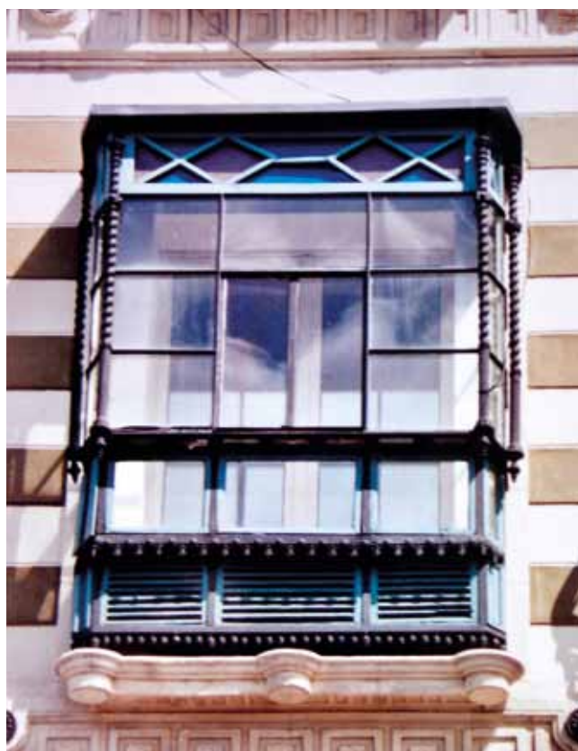
FIGURA 160: Detalle de la fachada.
