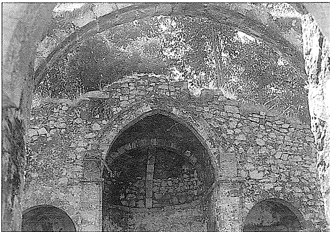
Fig. 2.—Arcos medievales de los ábsides y arco central de la época barroca.
