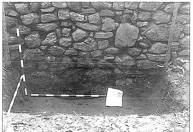
Fig. 5.—Muro lateral —SE— de la iglesia, sin enterramientos adyacentes.
