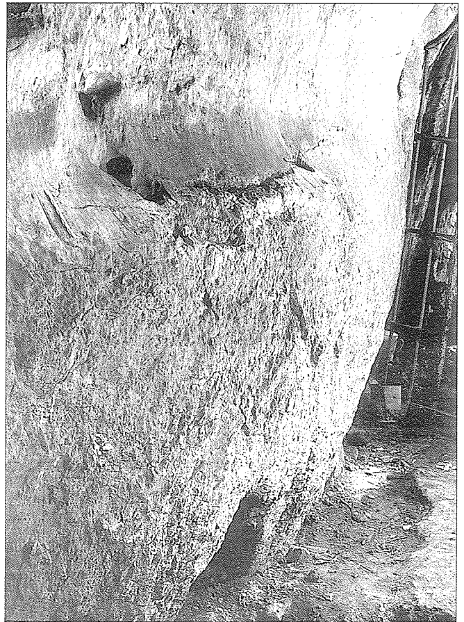
Fig. 16.—Vista general de la zona donde se localizan los grabados, con el detalle de la línea continua de desprendimientos en el muro lateral.
