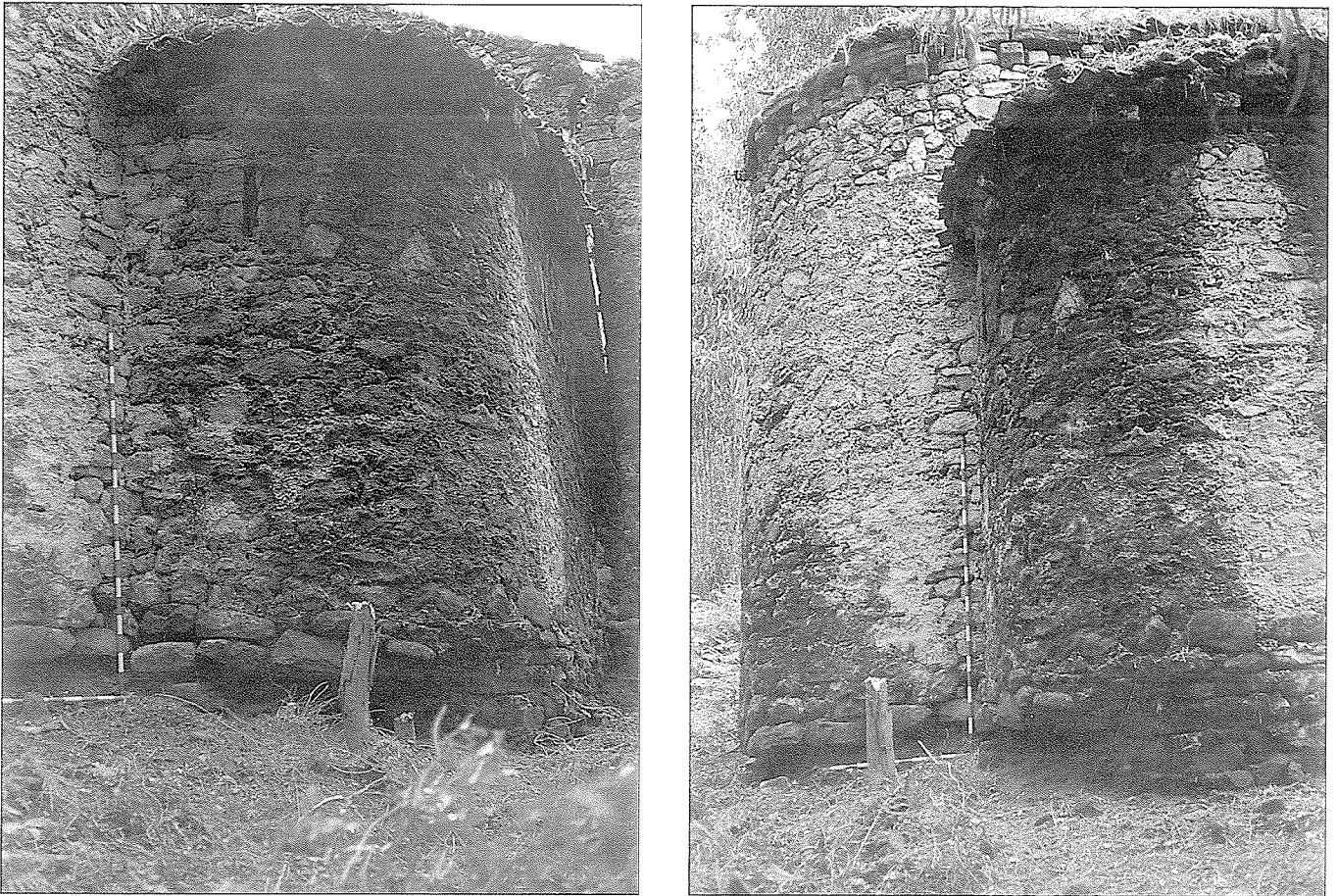
Fig. 6.—Vista exterior de los ábsides construidos sobre un escarpe del monte.
