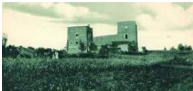
FIGURA 2: Imagen del palacio hacia el siglo XIX. Autor desconocido. En primer término la fachada SE. Por detrás aparece la torre NE, la más elevada del conjunto.
