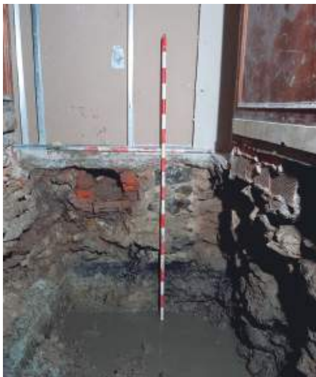
FIGURA 2: Imagen de la sección de la muralla. Una atarjea de ladrillo macizo alteró ya su cimiento. Se aprecia el horizonte basal y la cara externa (occidental) del cimiento.
