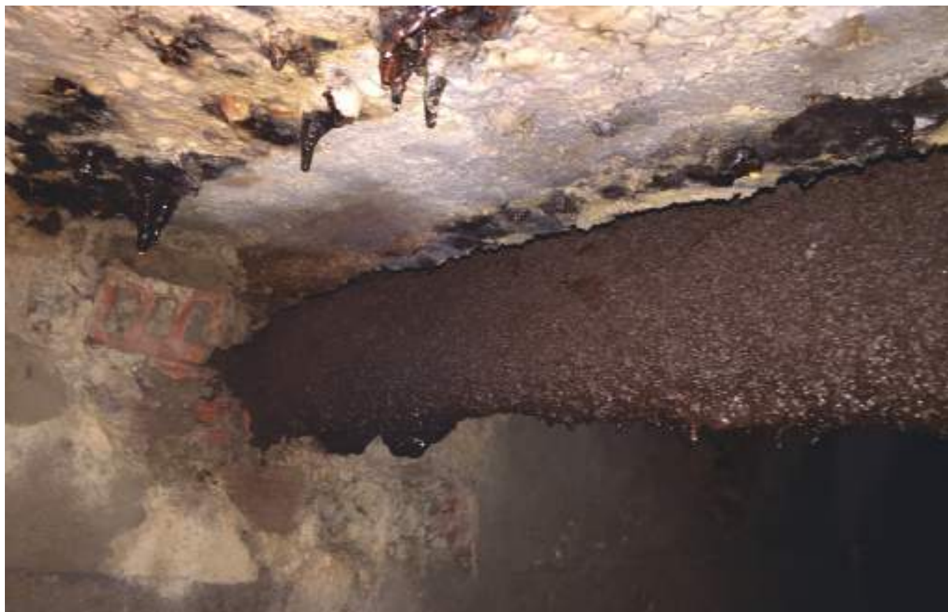
FIGURA 6: Detalle del entibado de madera empleado para la construcción del techo en alguno de los tramos del túnel.
