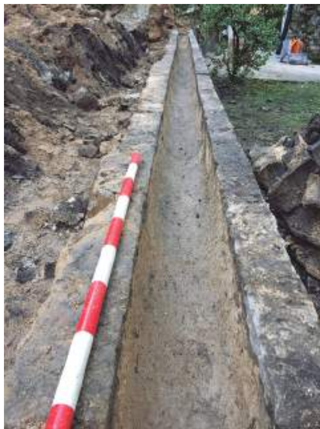
FIGURA 6: Sillares del sistema de canalización en los que encajaban los caños cerámicos.
