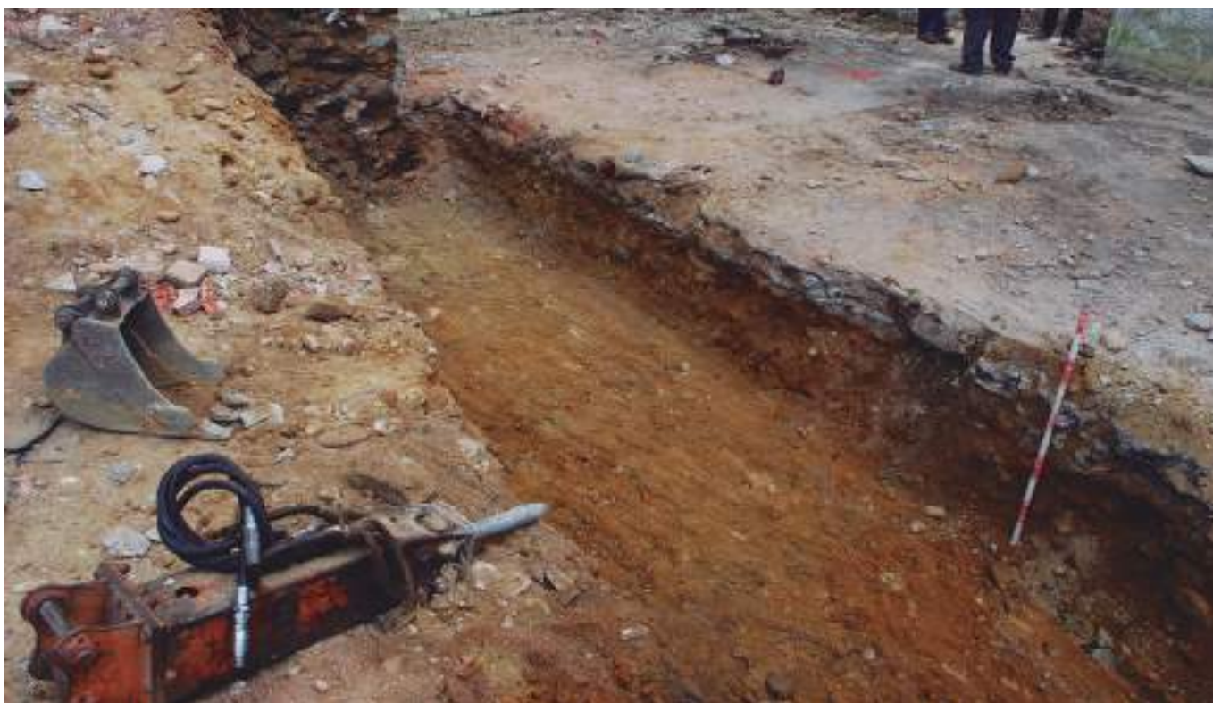
FIGURA 5: Trinchera excavada en el ángulo NO del edificio para buscar el cimiento de una posible cuarta torre. Los resultados fueron negativos. No se halló muro alguno.
