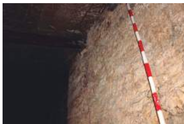
FIGURA 5: Documentación del paramento exterior de muralla a través del falso techo de la vivienda situada en el n.º 42. Se aprecia el tramo superior de la muralla, con fábrica de mampostería ordinaria de piedra caliza parcialmente recubierta con revocos de argamasa.
