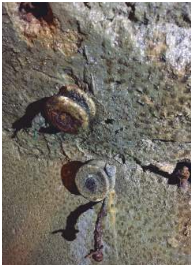
FIGURA 8: Detalle de los casquetes cerámicos para cable trenzado documentados en algunas zonas del túnel.
