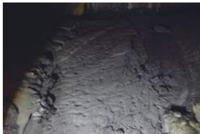
FIGURA 8: Gran acumulación de lodo, rellenando prácticamente el cauce, a la altura del Puente 2, en la Sala 1 (Fotografía: César García de Castro).
