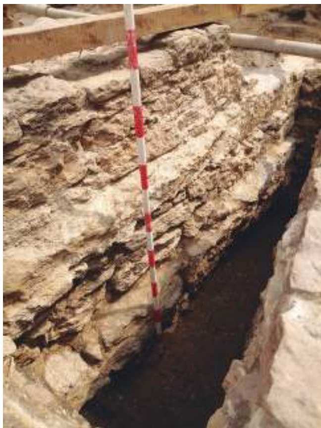
FIGURA 3: Imagen del alzado de MU-4. Los cimientos están contruidos con bloque ciclópeos.
