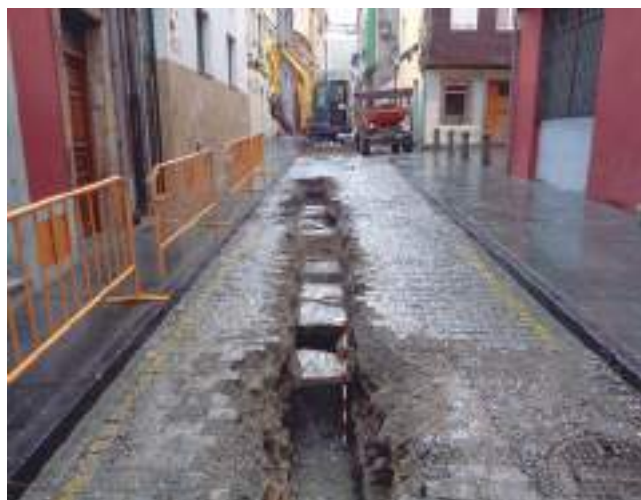
FIGURA 2: Vista del alcantarillado de losas en la zona media de la calle Vicaría, desde el sur (archivo de los autores).
