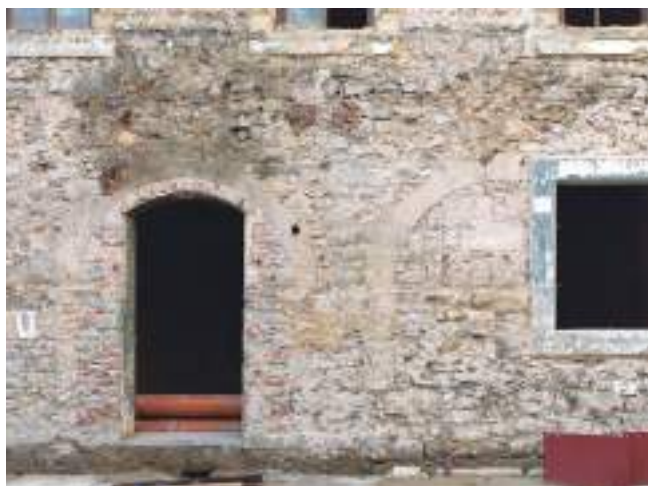
FIGURA 11: Restos de las arquerías del claustro (© Proyecto Tabacalera II, EST-AP, CSIC. Fotografía de Marcos Morilla).
