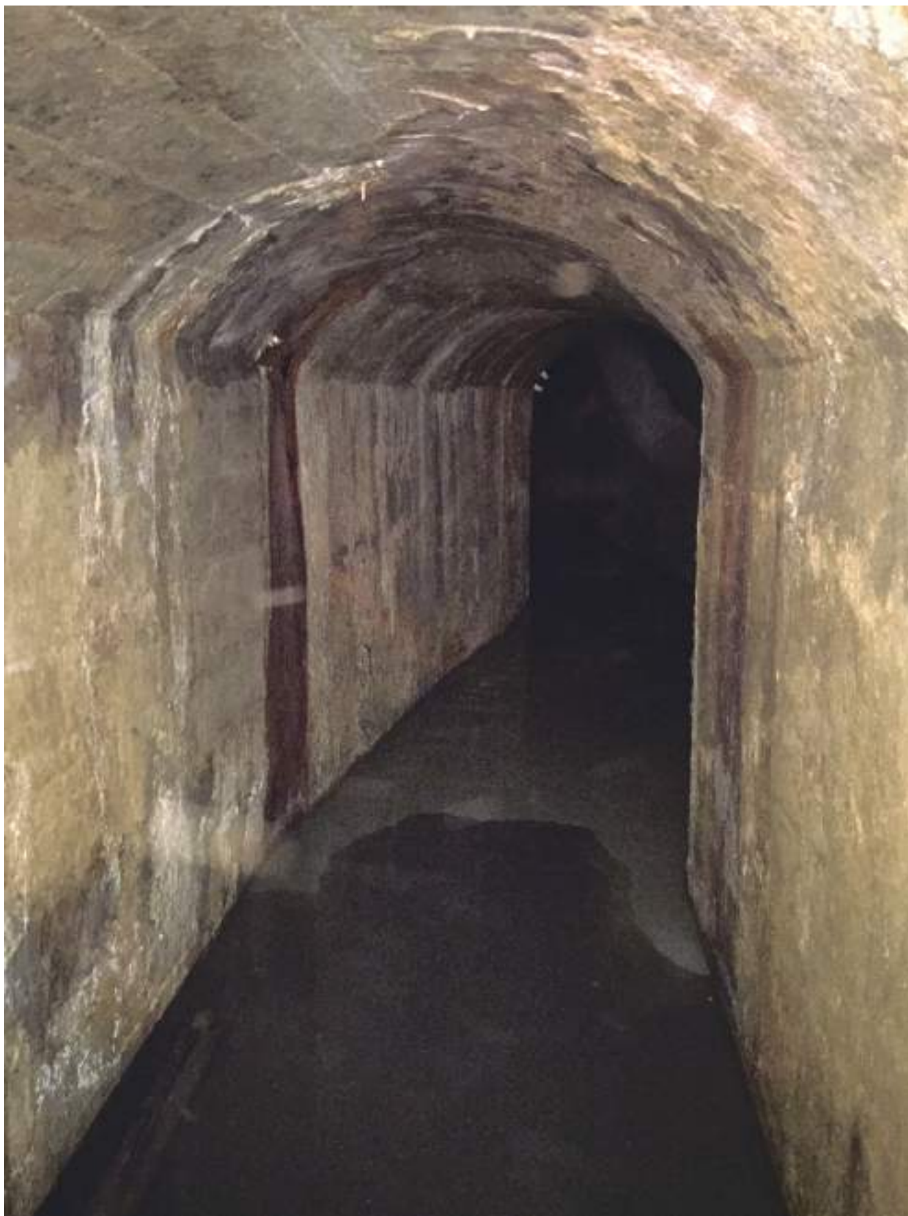
FIGURA 2: Tramo del túnel de Cimavilla documentado el día de su prospección.
