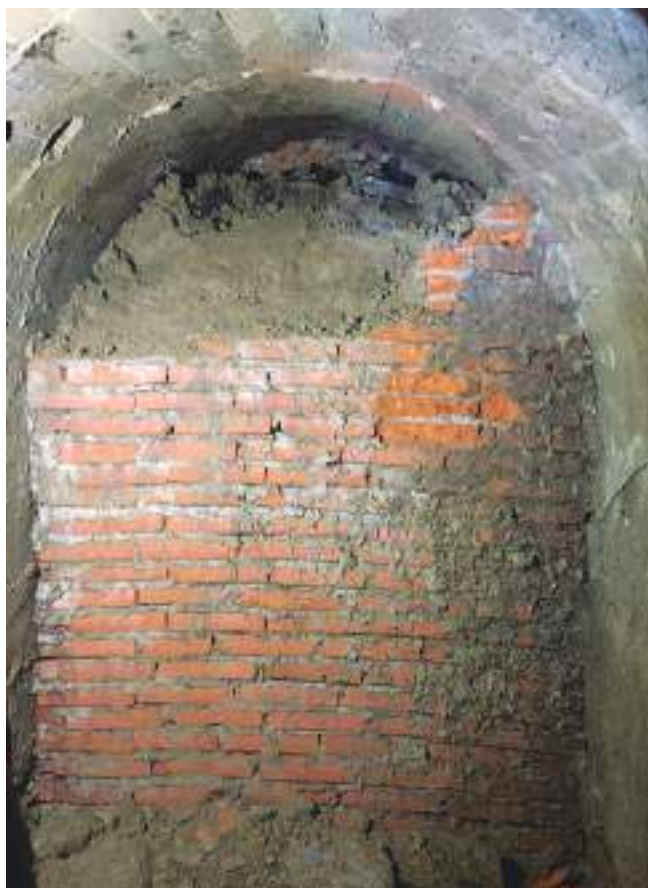
FIGURA 4: Tramo del túnel tapiado tras final del recorrido.
