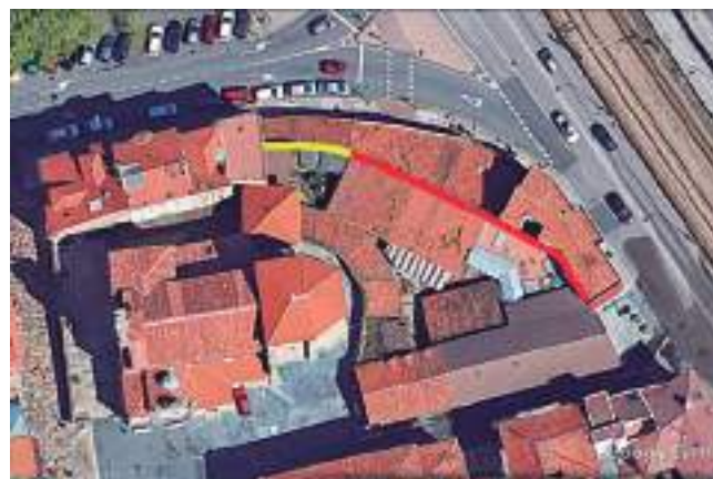
FIGURA 3: Vista aérea del tramo 1, con los vestigios de la muralla remarcados. En amarillo el tramo de muralla documentado, y en rojo la probable continuación de su trazado.
