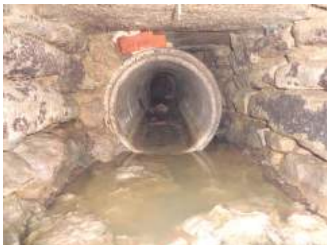
FIGURA 4: Detalle previo del interior del alcantarillado en la zona sur, desde el sur, con un tramo de tubería de saneamiento de hormigón dentro de los muros y losas de piedra (archivo de los autores).
