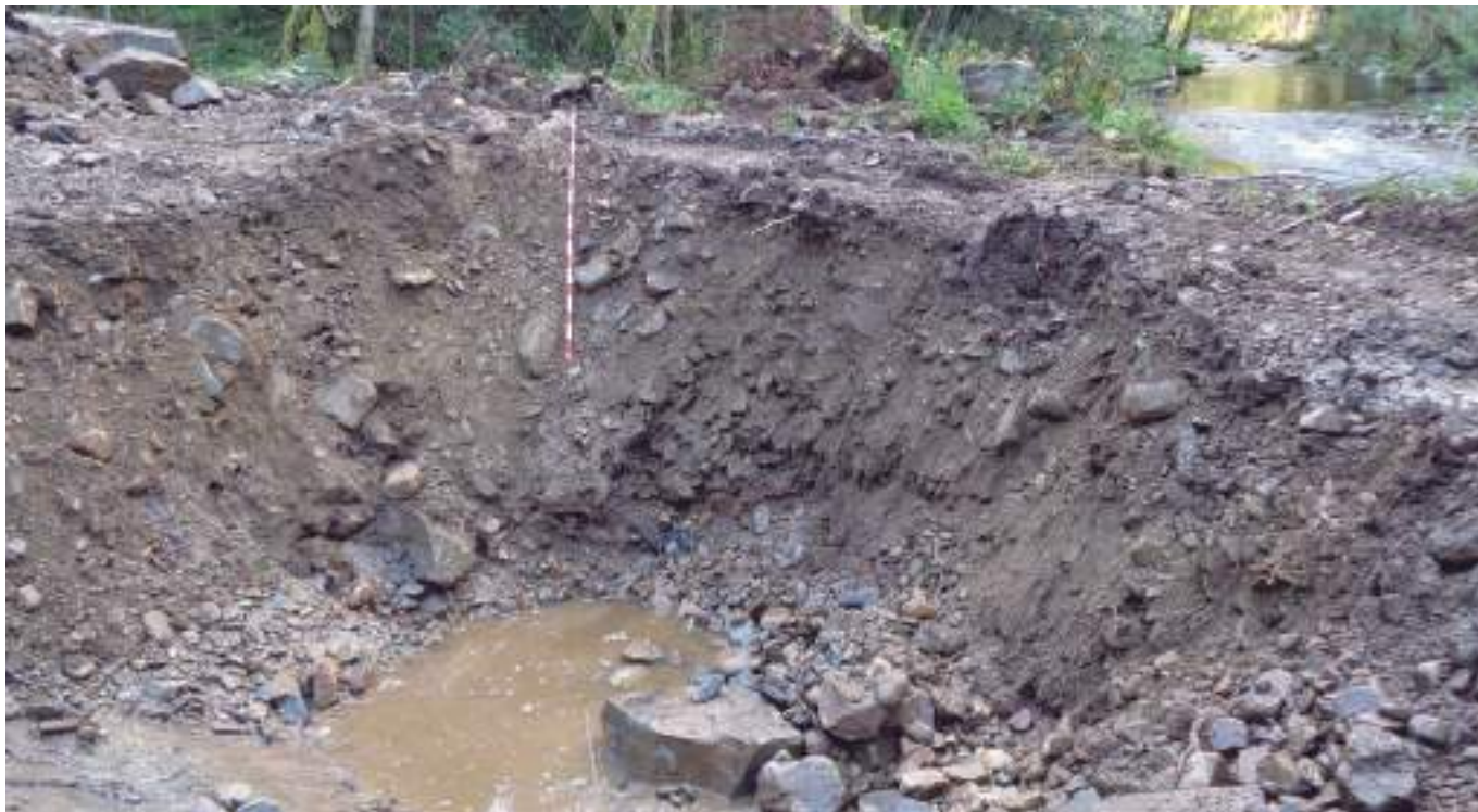
FIGURA 5: Vista de la zapata del apoyo este del puente nuevo, desde el norte. Se observa en el perfil sur el predominio de materiales de elementos aluvionares (archivo de los autores).
