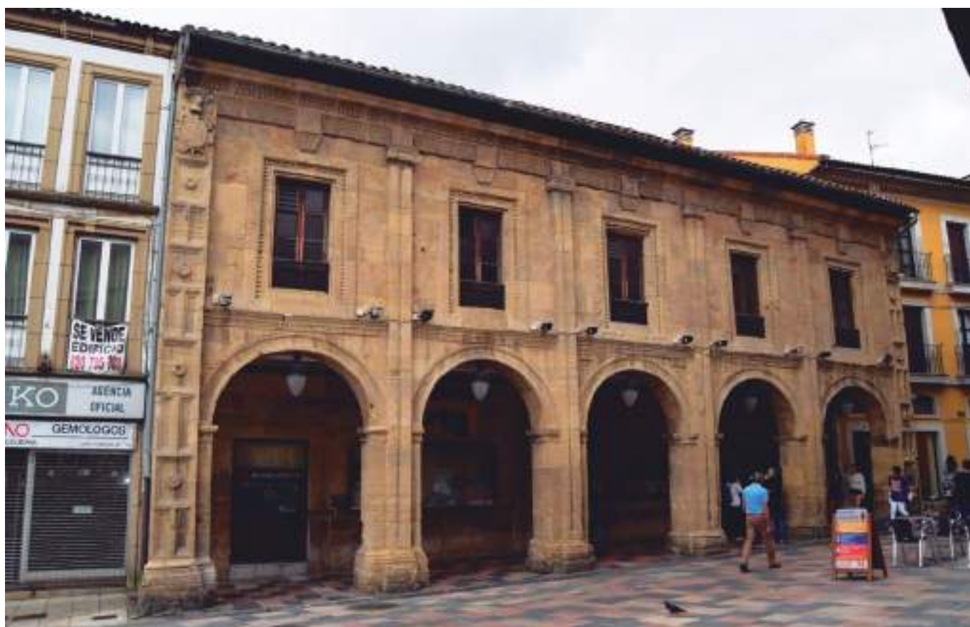
FIGURA 1: Vista de la fachada principal del palacio de Llano Ponte desde la plaza del Ayuntamiento.
