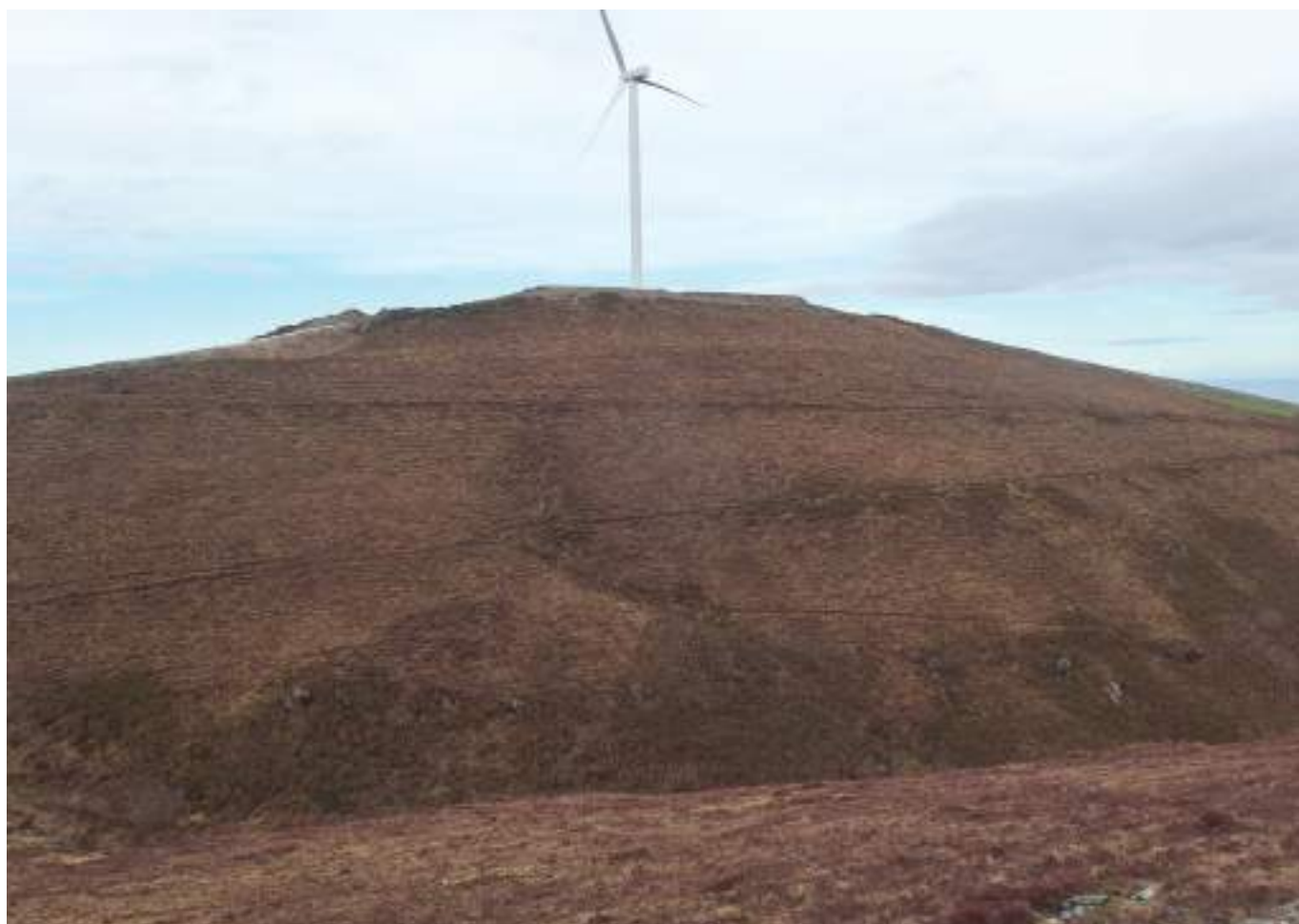
FIGURA 1: Vista general, desde el sureste, del trazado de la canalización ( El Caminón ) por la ladera este del Pico Muñón, en cuya cumbre se ha levantado el aerogenerador CVI-12 del Parque eólico Cordel Vidural.
