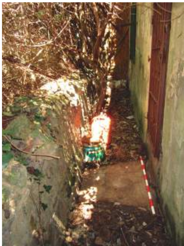
FIGURA 12: Vista del paso de ronda y del parapeto interior del adarve de la muralla, al que se adosa la fachada trasera del n.º 2 de la calle de El Muelle. El paso de ronda presenta una anchura de 83,5 cm (una vara castellana) y el parapeto interior conserva una altura media de 105-110 cm.
