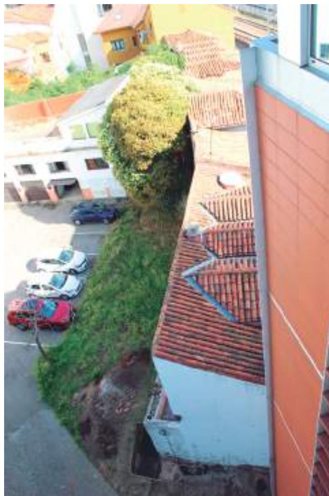
FIGURA 7: Detalle del sondeo n.º 2, excavado al pie de la esquina suroeste de la vivienda-portal n.º 6 de la calle de El Muelle. Se aprecia como los vestigios de la muralla han sido cortados y enrasados con el cerramiento de la vivienda, mientras que el adarve ha sido incorporado como patio trasero en altura de la misma.
