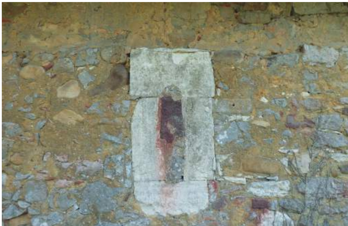
FIGURA 2: Aspillera en muro norte.
