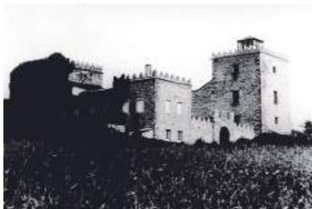
FIGURA 3: Fotografía de las primeras décadas del siglo XX. Autor desconocido. El edificio presenta una fisonomía cercana a la que ofrecía en el momento de inicio de la rehabilitación actual.
