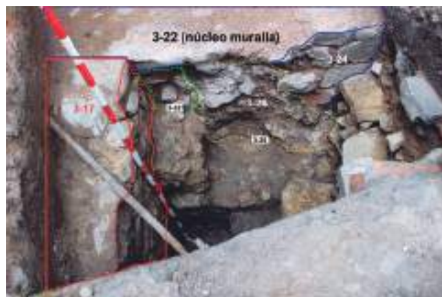
FIGURA 16: Sondeo 3. Sector extramuros. Unidades estratigráficas murarias en el paramento exterior de la muralla.
