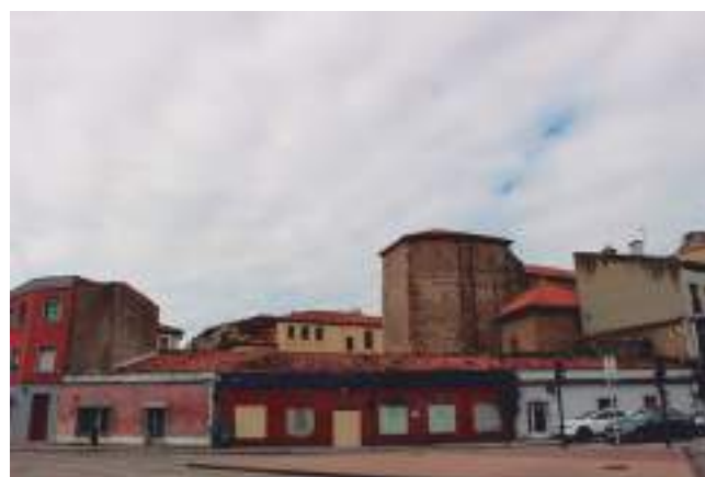
FIGURA 4: Vista del tramo 1 desde la calle de La Muralla. Se aprecian las tres edificaciones de planta baja (n.º 42, 44 y 46) y el edificio de dos pisos (n.º 48) que se adosan al paramento exterior de la muralla.
