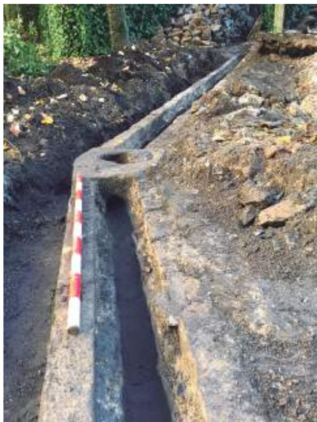
FIGURA 4: Imagen de la canalización en piedra con tubería cerámica.
