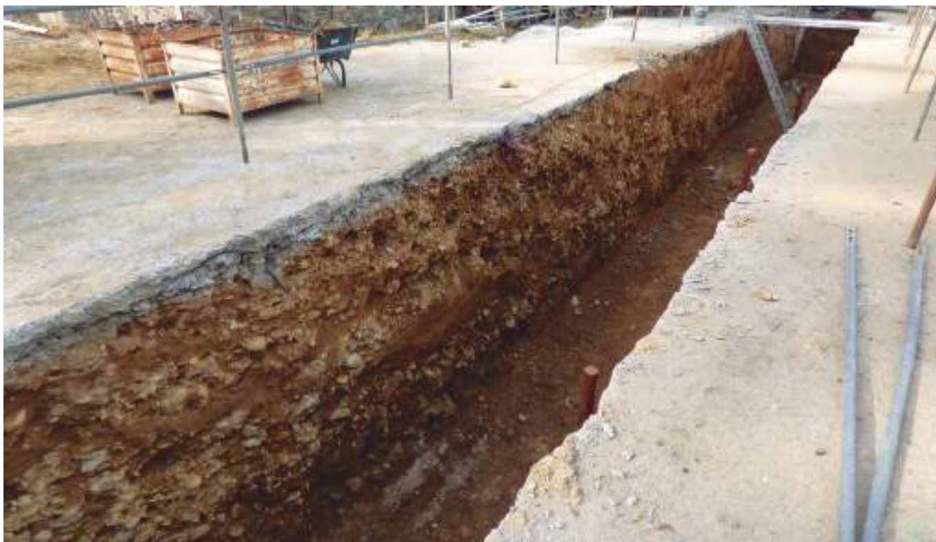
FIGURA 4: Gran trinchera abierta para la instalación de acometidas entre el palacio y el nuevo edificio auxiliar. Bajo el solado actual la estratigrafía es completamente natural, típica de la rasa costera en esta zona.
