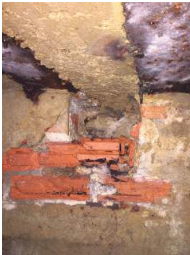
FIGURA 9: Foto detalle del sistema de raíles y hormigón empleado para la construcción del túnel en la zona del techo en alguno de los tramos.
