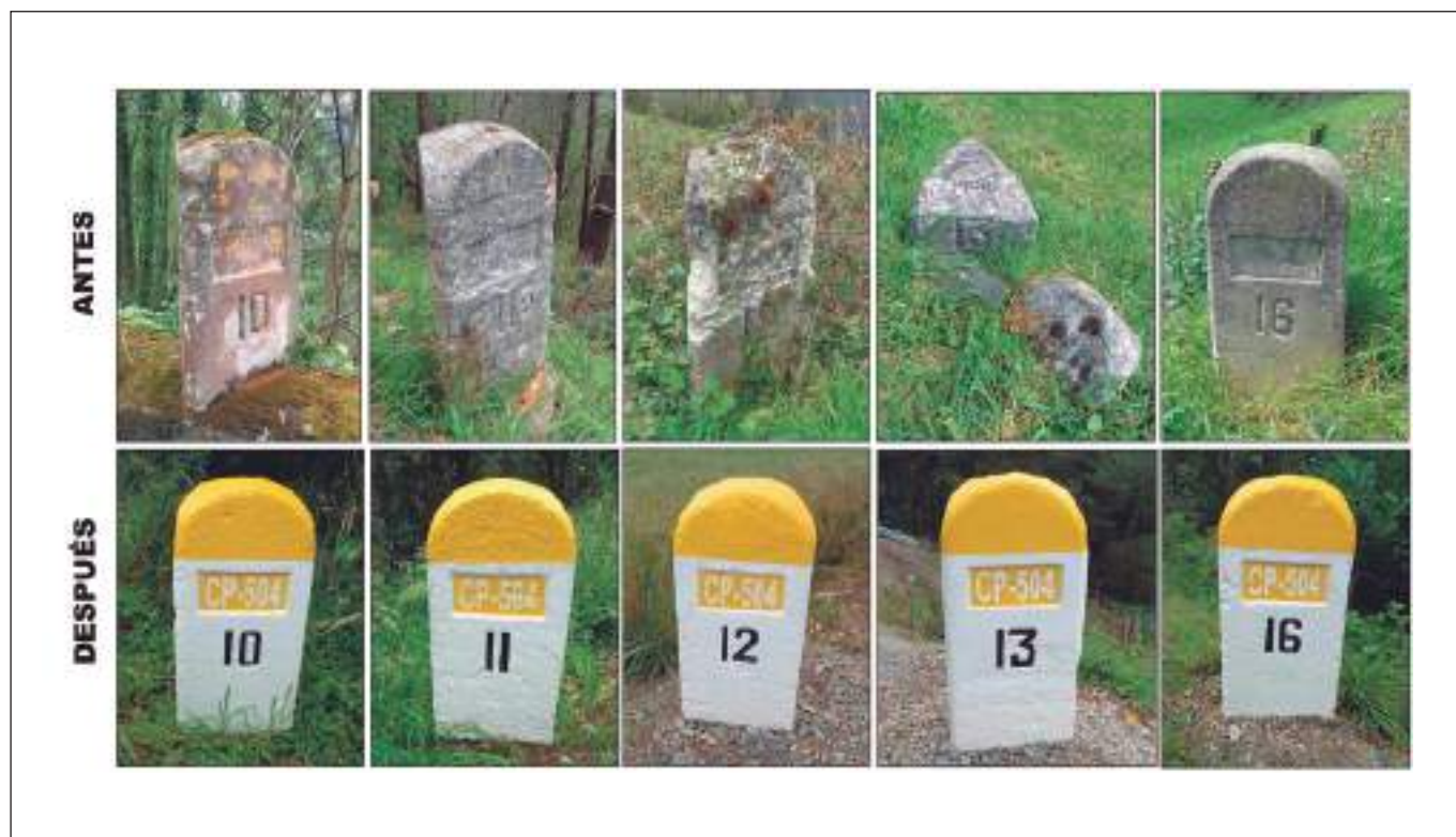
FIGURA 9: Vistas del antes y el después de los hitos kilométricos recuperados, restaurados y recolocados (archivo de los autores).
