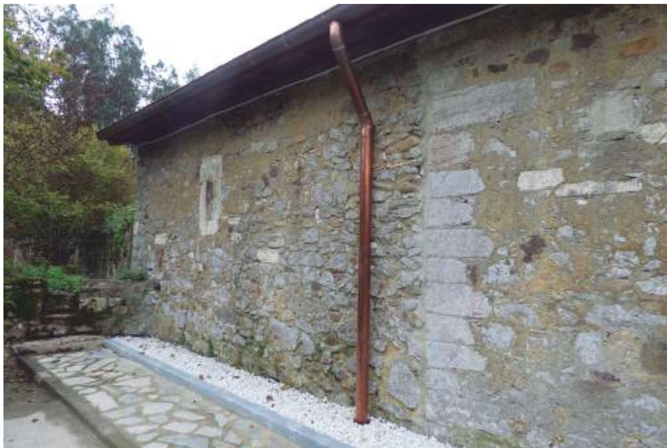
FIGURA 9: Vista parcial del muro norte en el que se aprecia cómo el paramento del cuarto añadido se adosa a la cadena de sillares del transepto. La aspillera resulta probablemente un reaprovechamiento de una edificación anterior.
