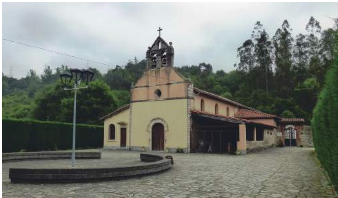
FIGURA 1: Imagen de la iglesia anterior al inicio de las obras de reparación (2017).
