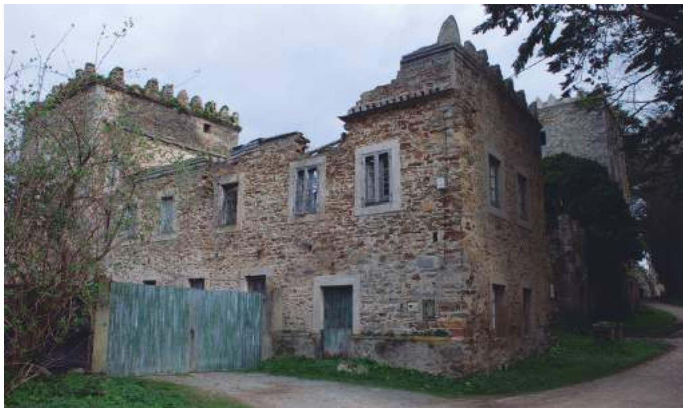
FIGURA 1: Vista general del palacio desde el camino de Lineras a Barres. En primer término la torre SE.
