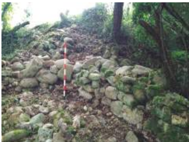
FIGURA 4: Fotografía de la construcción de planta redonda ubicada en el extremo septentrional del enclave, superpuesta a los posibles restos a los que hace referencia el Diccionario de Pascual Madoz.
