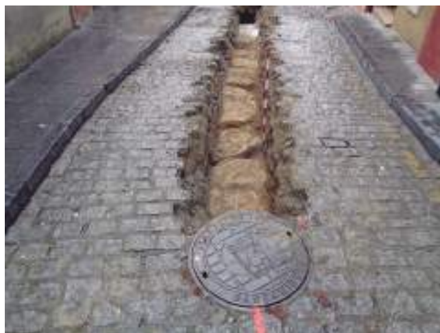
FIGURA 3: Detalle del alcantarillado de losas en la zona sur de la calle, en uso como saneamiento antes de su renovación, desde el norte (archivo de los autores).
