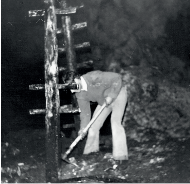
▲ Desmontaje de la estructura instalada en Llonín para la fermentación de quesos. 1971. Archivo Personal. Familia Berenguer Díez
